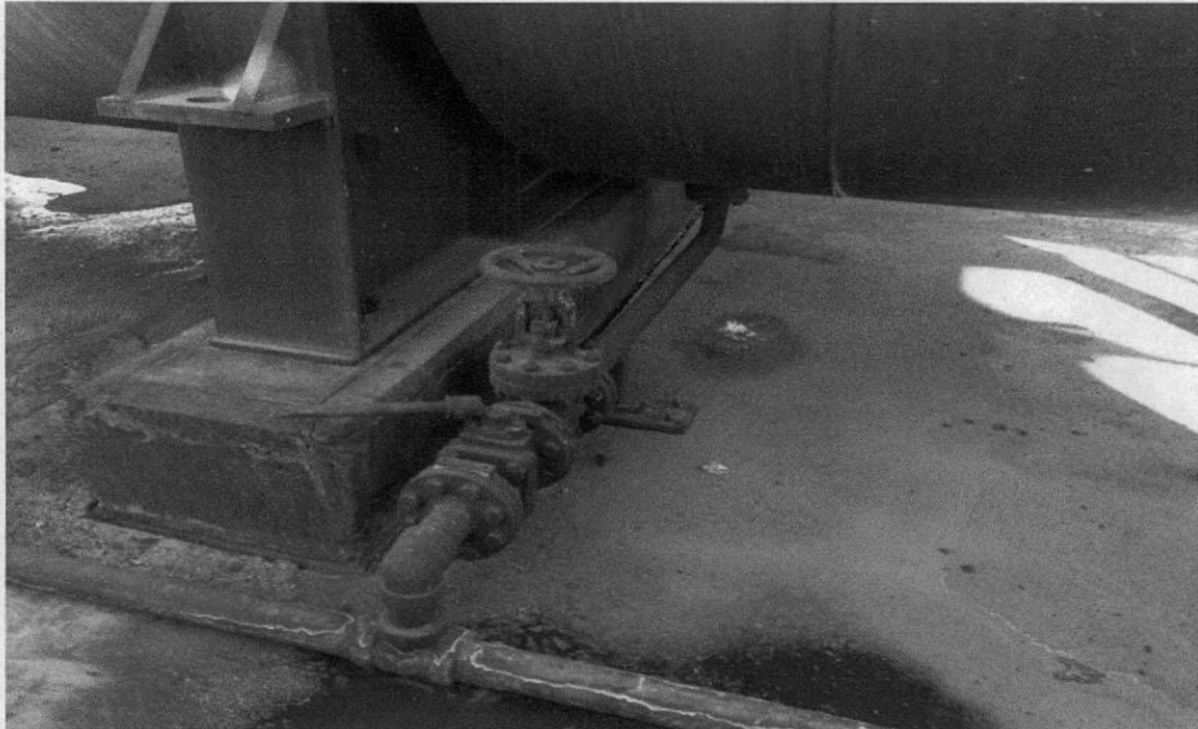
Imagen N°9: Desconexión y retiro cañería despiche bajo calentador
