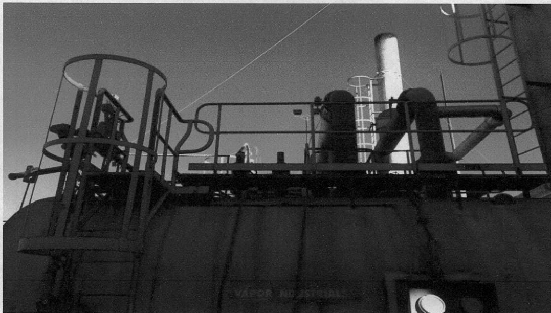
Imagen N°12: Retiro de escalera de gato y válvulas de seguridad
