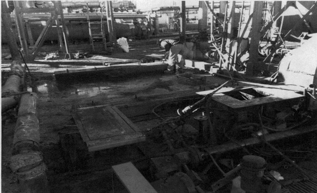
Imagen N°17: Limpieza de base y pernos de anclaje para instalar calentador nuevo
