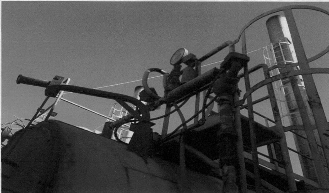
Imagen N°22: Instalación de escala de gato, plataformas, sensores, cables
