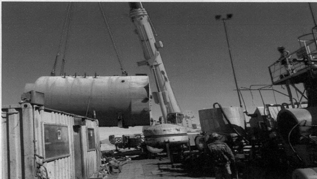
Imagen N°18: Instalación del calentador N°2 de refino
