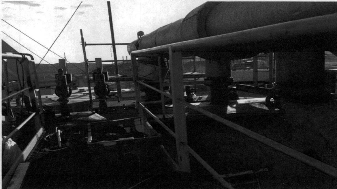
Imagen N°25.- modificación e instalación de entradas de calentador
