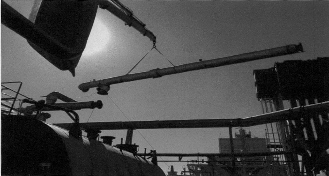
Imagen N°6: Retiro de codos de cañerías de alimentación sobre calentador N°2 de refino
