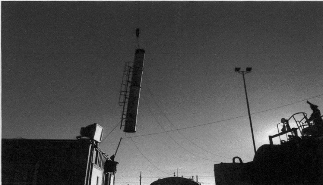
Imagen N°4: Retiro de tensores y chimenea de calentador N°2 de refino
