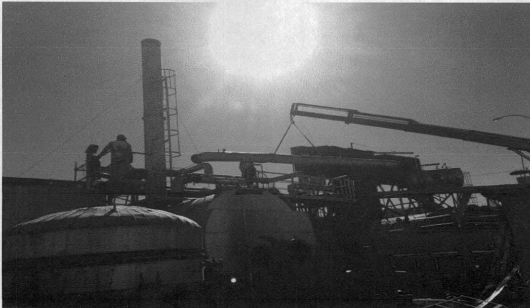
Imagen N°24: Instalación de cañerías de alimentación en general
