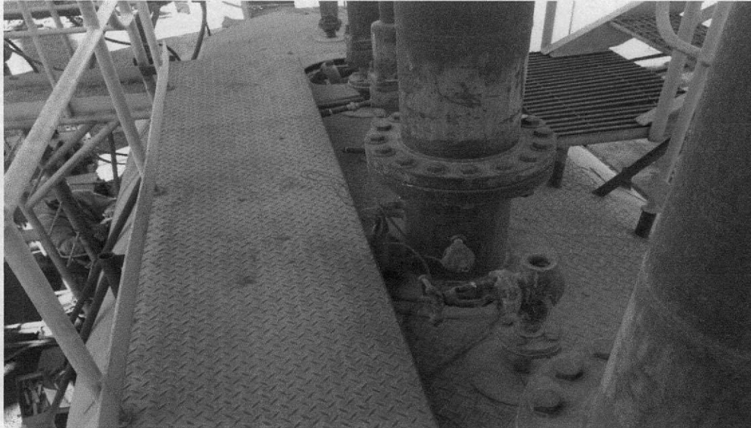
Imagen N°11: Retiro de plataformas superiores del calentador
