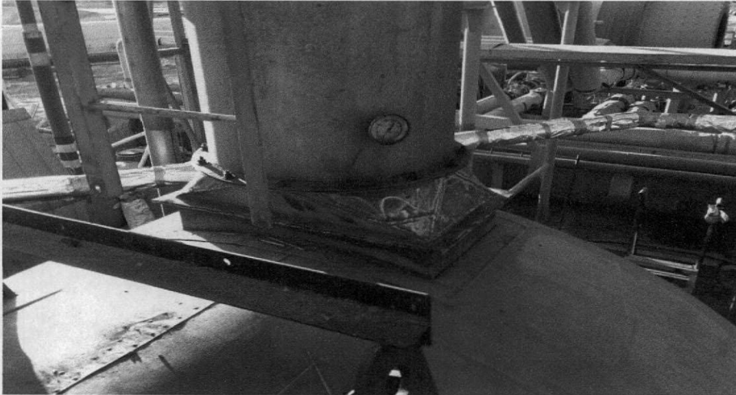
Imagen N°23: Modificación e instalación de chimenea
