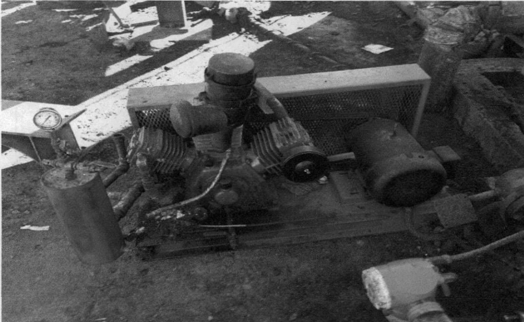
Imagen N°15: Retiro de base y bomba de calentador
