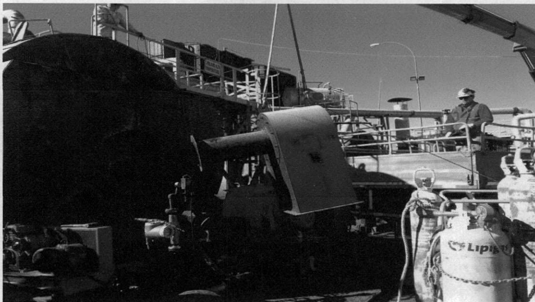
Imagen N°14: Retiro de coraza carrete soporte protección de quemador
