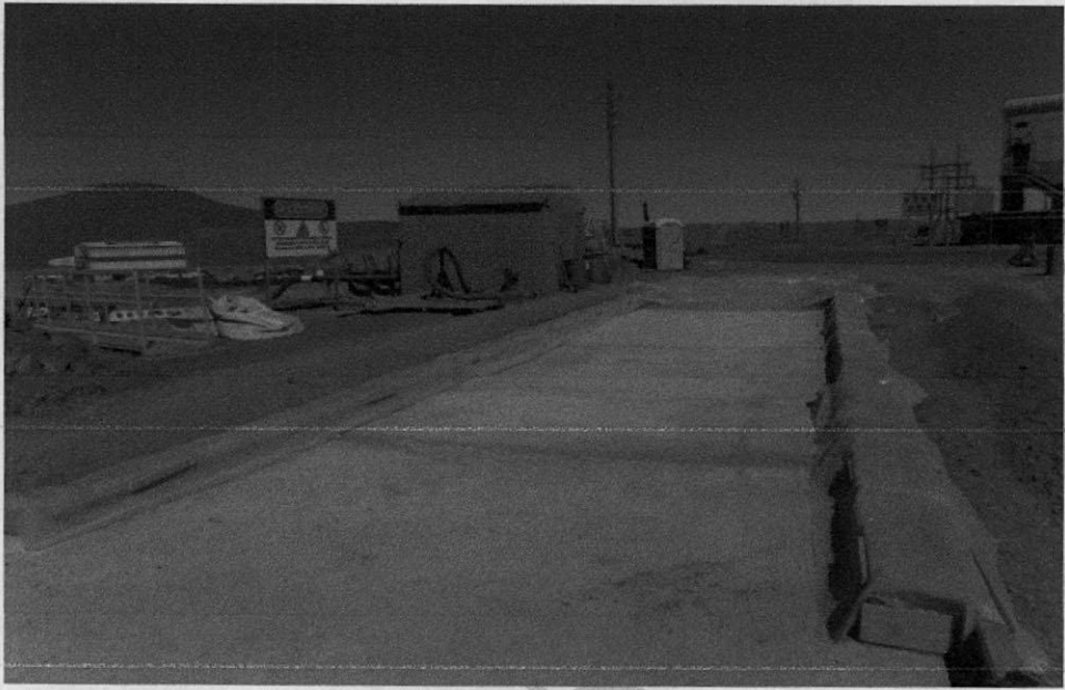
Imagen 1.-Término de losa impermeable.
