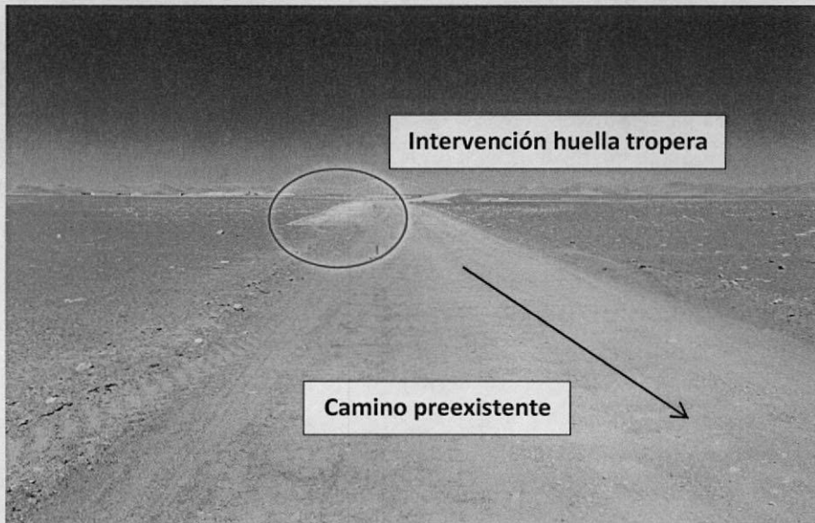
Figura 3. Tramo de intervención Huella Tropera 1-2 junto a camino existente.
