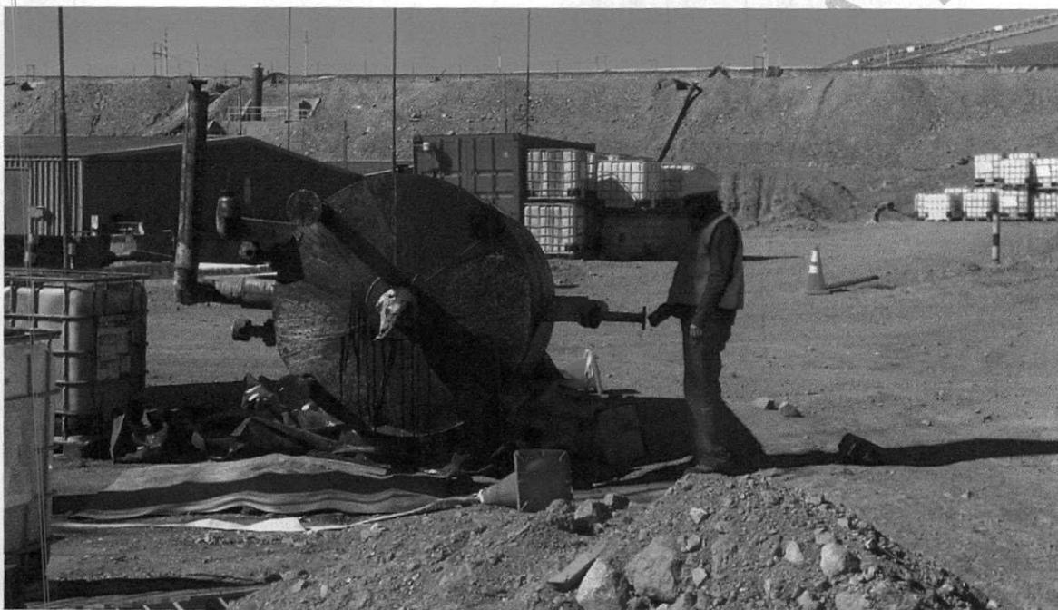
**Imagen N° 2:** Verificación de gases con explosímetro.
