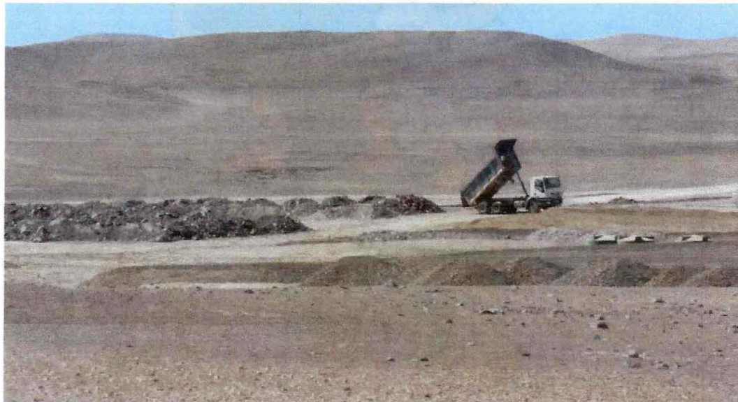
Figura 5: Detalle de área de trabajo para habilitación de plataformas para electrowinning (Marzo 2013).
