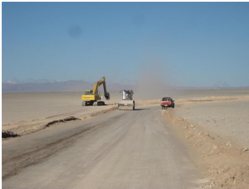
Figura 4. Excavación zanja circuito eléctrico N°9 en vereda Norte
