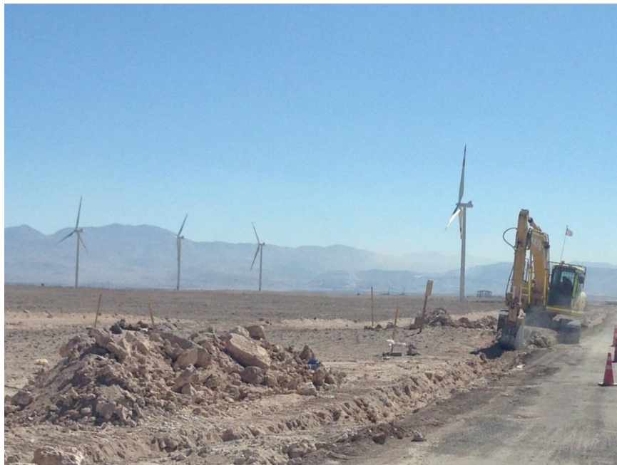
Figura 9. Excavaciones para zanja eléctrica cercana a emplazamiento del rasgo VDLV 15.
