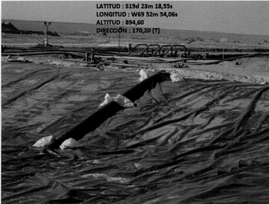
Una vez habilitada la piscina N°7, esto con respecto a la impermeabilización (B.3) y sistema de detección de fuga (B.4), se desconectó del sistema la piscina N°6, la cual se mantendrá vacía (Imagen 3)
