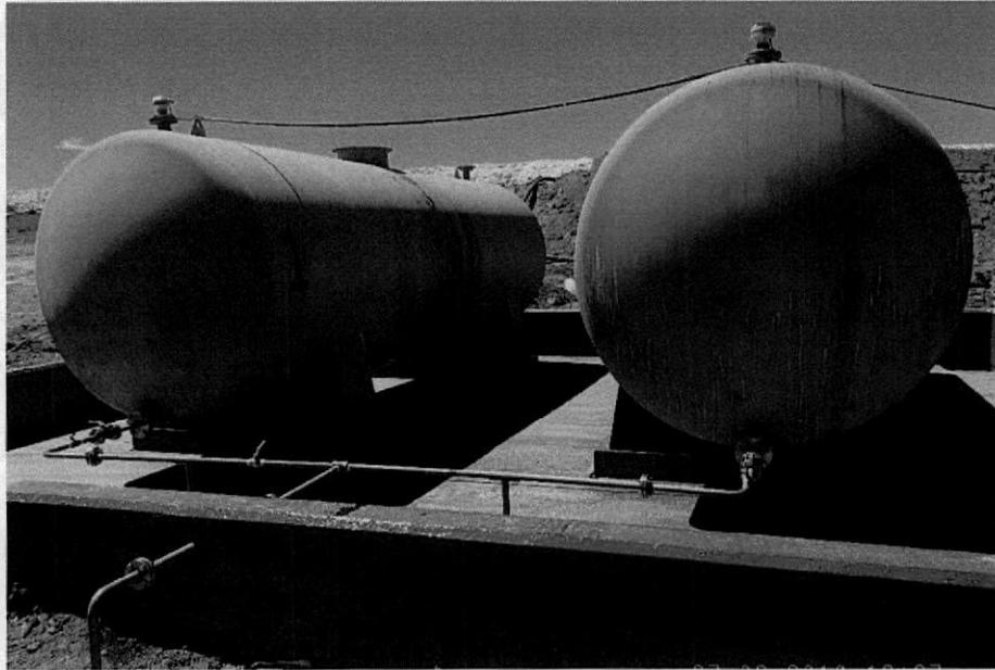
**Imagen 9. Estanques de ácido instalados**
