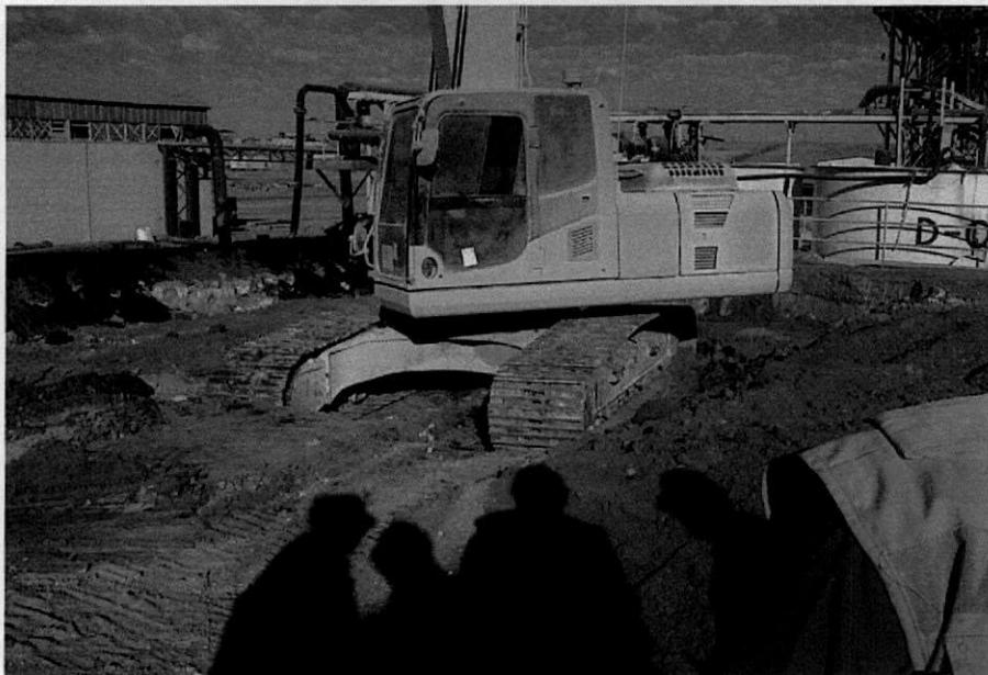
2.- Se rellenó con material estabilizado en dos capas de 40 cm cada una. Una vez depositada la primera capa, se compactó con el rodillo compactador y se rellenó con la segunda capa a la cual se le realizó el mismo proceso que la primera (ver fotos).
