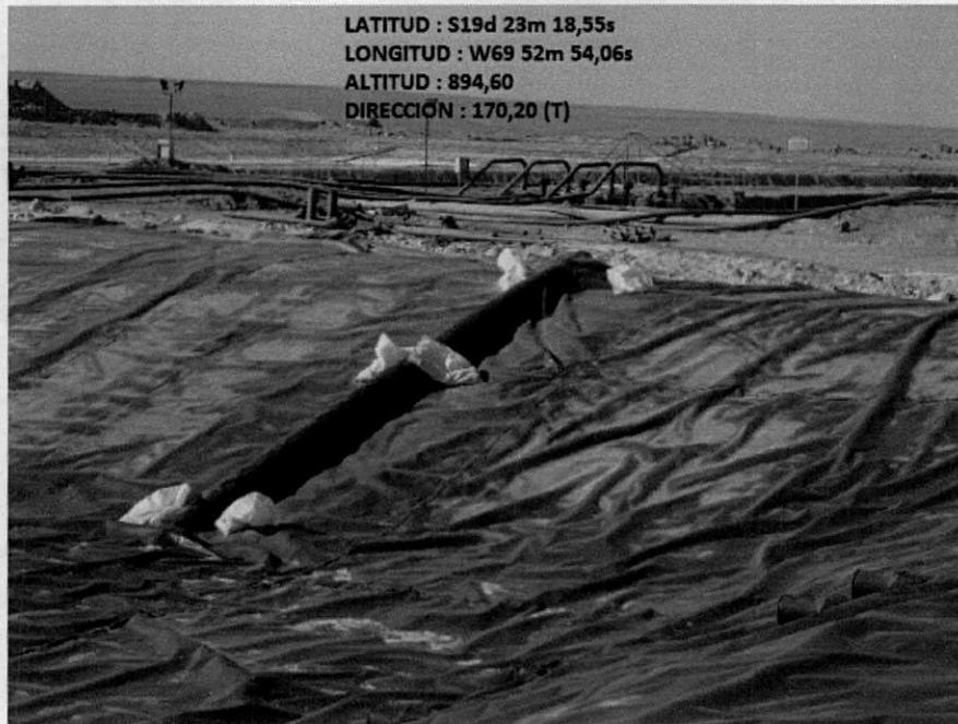
**Imagen 3. Impermeabilización con HDPE 1 mm**
