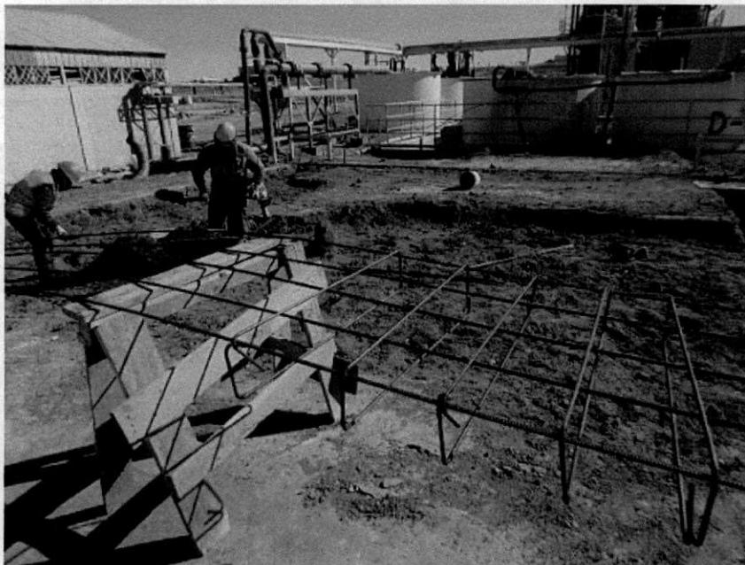
**Imagen 9. Construcción avanzada de radier de hormigón**
