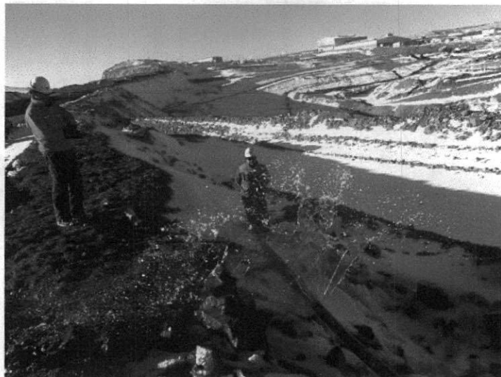
Fig 4. Drenado de cañería Ptas-QB
