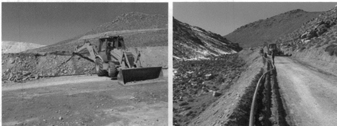
Imagen N°5: Trabajos de movimiento de tierra cubriendo tubería.
