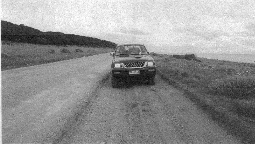
Usurpación de terreno y daño a la propiedad privada. El camino privado originalmente de máximo 6 metros de ancho (según puede constatare en EIA), hoy mide hasta 11 metros en algunos tramos. En la fotografía se puede apreciar la a mano derecha parte del ensanchamiento del camino y a mano izquierda, el camino original.
