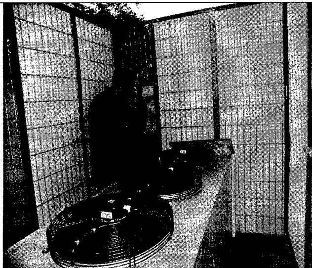
INSTALACION CUBIERTA EXTERIOR
