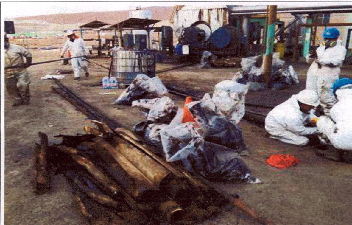
Fotografía N° 10 Limpieza de canaletas en sector de calentadores de refino
