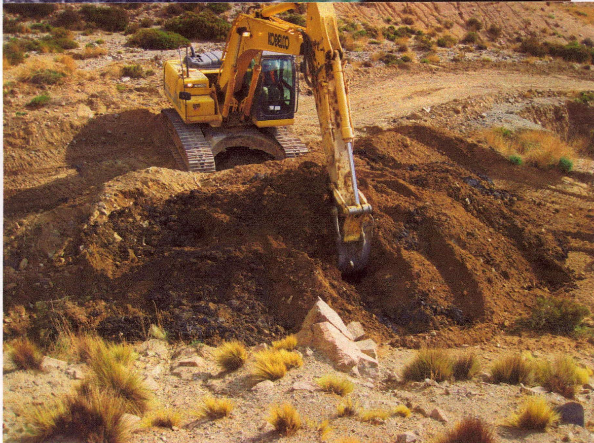
Fotografía N° 12 Limpieza de zanjas de decantación al pie de la descarga de PTAS
