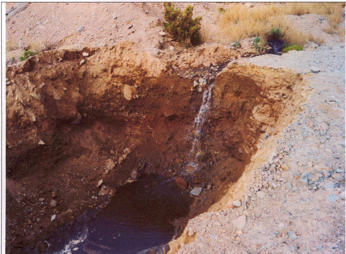
Fotografía N° 4 Calicata Contención 1 19 K 517559,9 7675925,6
