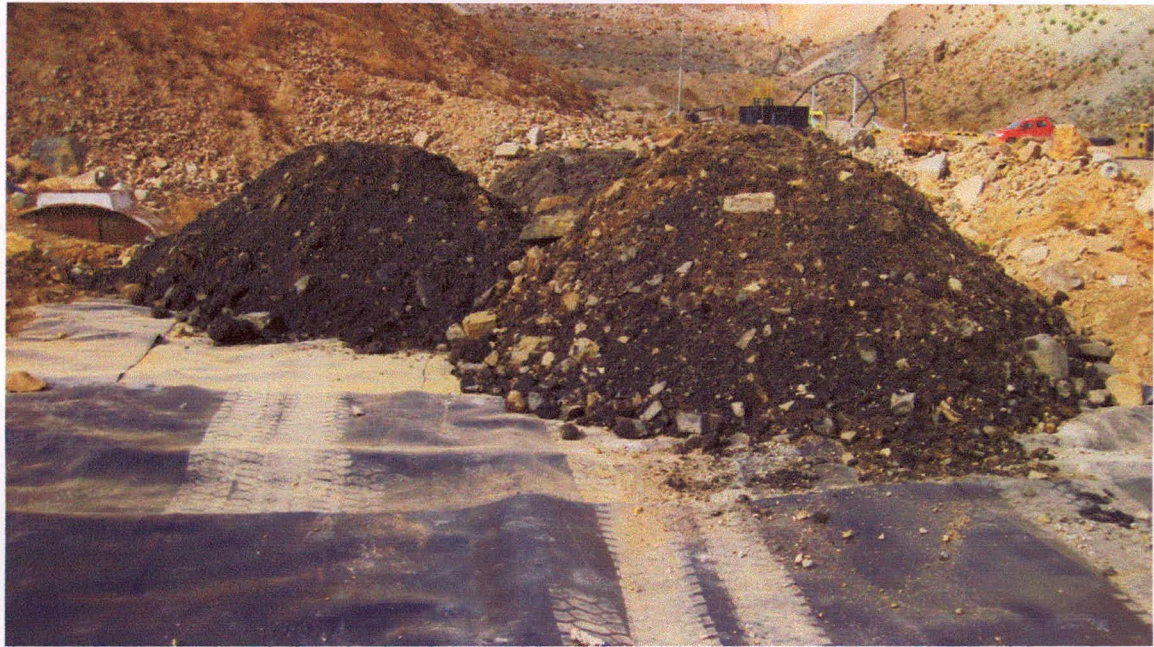
Fotografía N° 13 Punto de Acopio de material retirado de las zanjas de decantación ubicado pie de la descarga de PTAS
