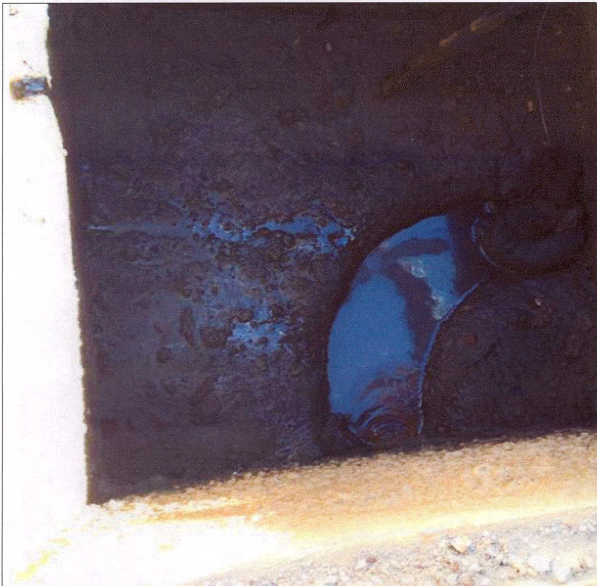
Fotografía N° 7 Cierre de Alcantarillado en Planta de refino 521149N 7677476 E
