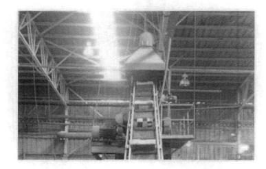
Con posterioridad a la instalación de la nueva campana de extracción y con la finalidad de confirmar las condiciones ambientales de este sector, se solicitó a ACHS que realizara mediciones de gases ácidos en el ambiente laboral y a SERPRAM que midiera gases que salen por la chimenea, con el fin de cuantificar correctamente las emisiones de gases ácidos en este sector.
