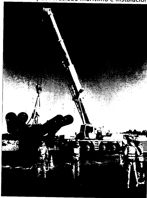
Foto N°12 y 13: Traslado marítimo e instalación primer manifold
