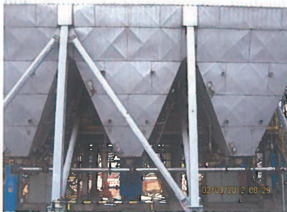
Foto 2. Silos de acumulación de material residual
