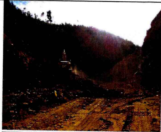
Foto 4: Muestra máquina excavadora desplazándose a la cancha de extracción de áridos.
