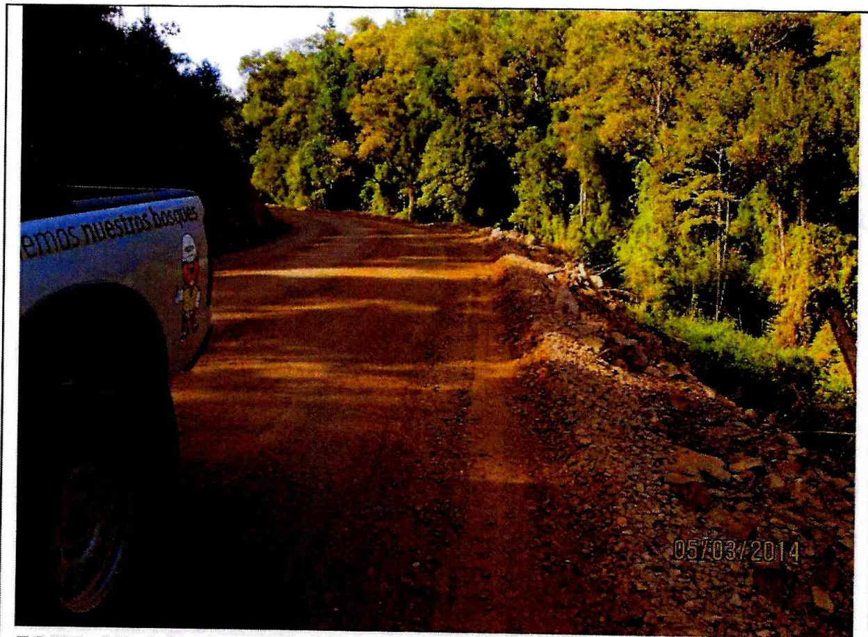
FOTO 10: Muestra alteración de cauce, por mejoramiento de camino de acceso al campo de faenas extractivas. Extensión aproximada, 300 metros.
