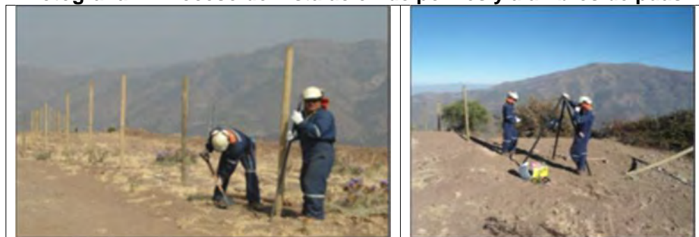
Fotografía-2: Proceso de instalación de polines y alambres de púas
