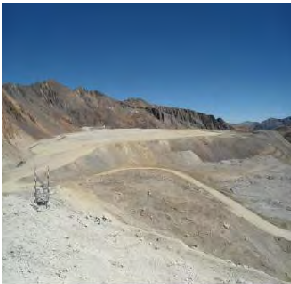
Figura 6 - Superficie del depósito perfilada para drenaje a los canales de contorno
