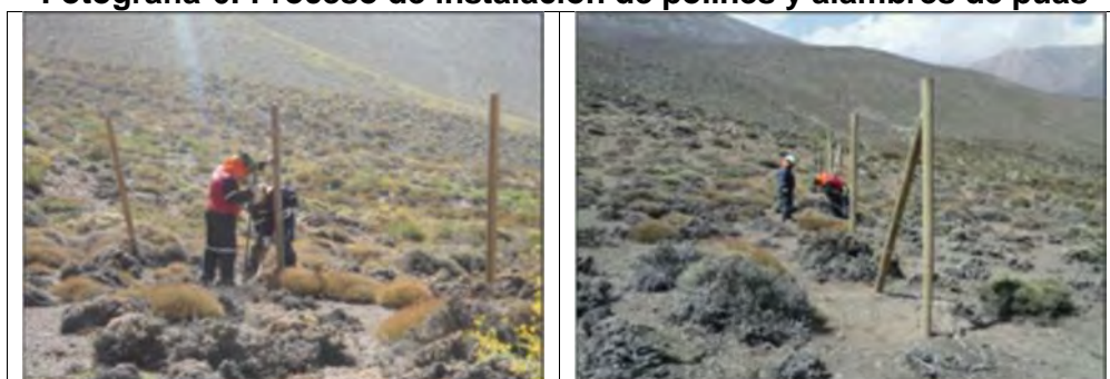
Fotografía-6: Proceso de instalación de polines y alambres de púas
