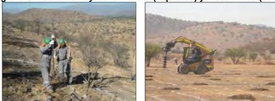
Fotografía-5: Faena de hoyadura manual (izquierda) y mecanizada (derecha)
