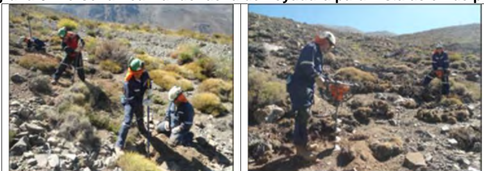
Fotografía-5: Personal realizando faena de hoyadura para instalación de polines.
