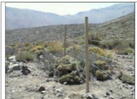
Fotografía-7: Cerco construido con las 6 hebras de alambres de púas
