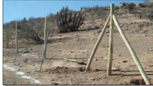
Fotografía-2: Etapas de construcción del cerco
