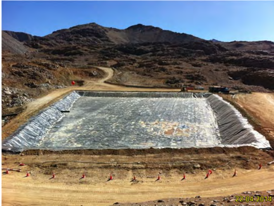
Figura 4 - Laguna 4 al finalizar la impermeabilización
