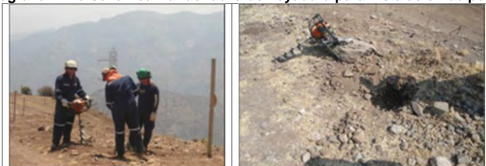
Fotografía-1: Personal realizando faena de hoyadura para instalación de polines
