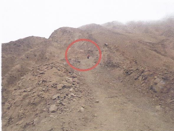
Figura 4. Obras viales observados en la parte alta del acantilado, por fuera de los 80m de la línea de marea.
