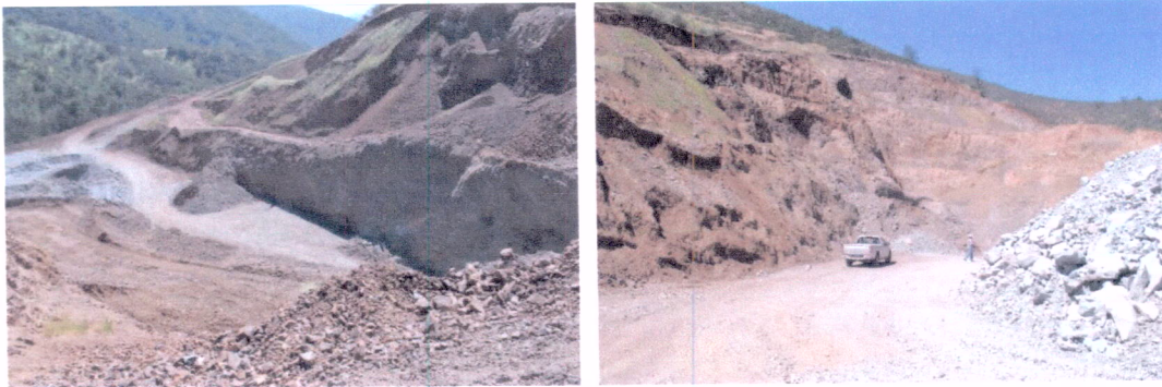
Grupo de imágenes Nº 4: Plataforma de explotación Nº 2 y sondaje minero. (Unidad de Evaluación Ambiental I.M.Maipú 21/10/2014)
