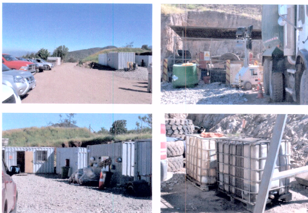
Grupo de imágenes Nº 1: Campamento minero, bodegas y contenedores de almacenamiento de combustible sin medidas de contención ante derrames. (Unidad de Evaluación Ambiental I.M.Maipú 21/10/2014)
