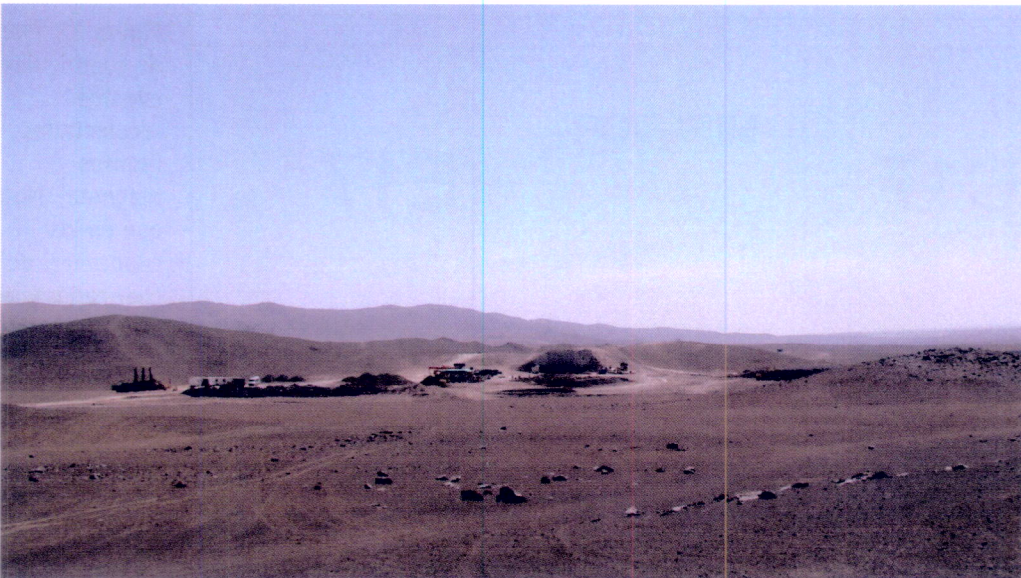
Figura 10: Vista general del área de chancador en pleno proceso de construcción. Agosto 2013.
