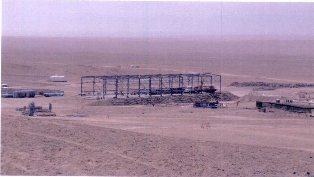
Figura 13: Detalle de obras en el sector de electrowinning. Nótese en el fondo estanques de combustible y garita de control de acceso. Agosto 2013.
