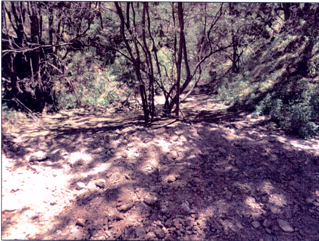
Imagen de intervención de quebrada.
