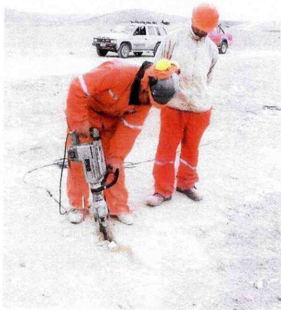
Figura 1. Perforación capa de caliche
