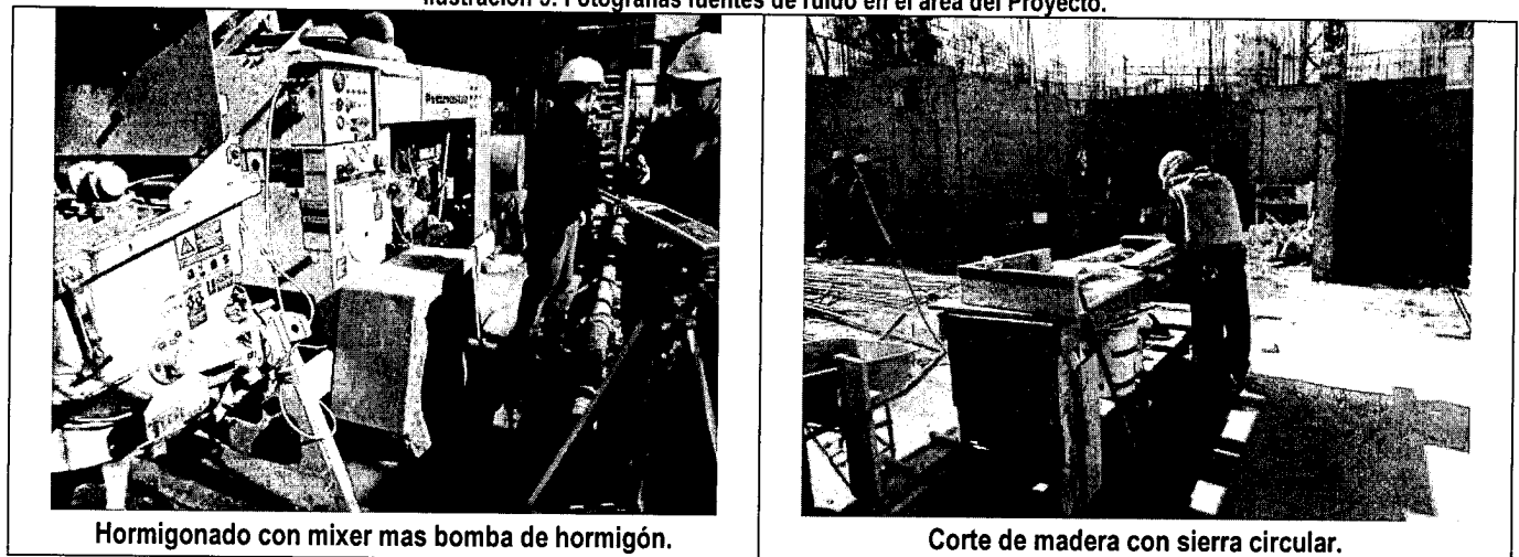
Ilustración 5: Fotografías fuentes de ruido en el área del Proyecto.
