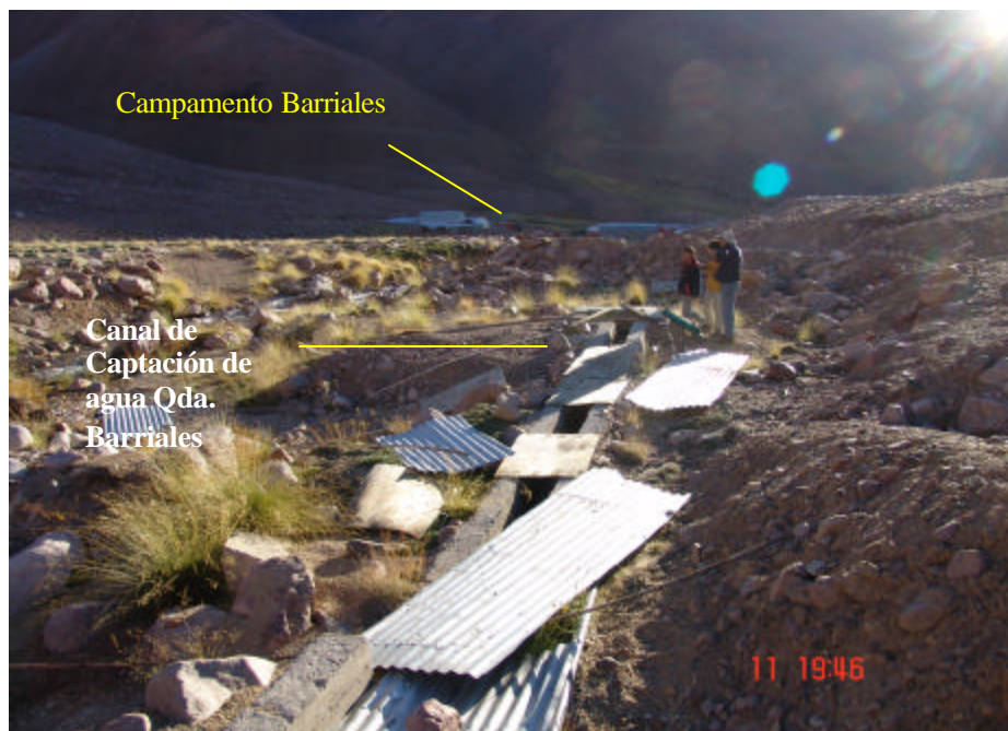
Punto de captación de agua quebrada Barriales para el Campamento.
