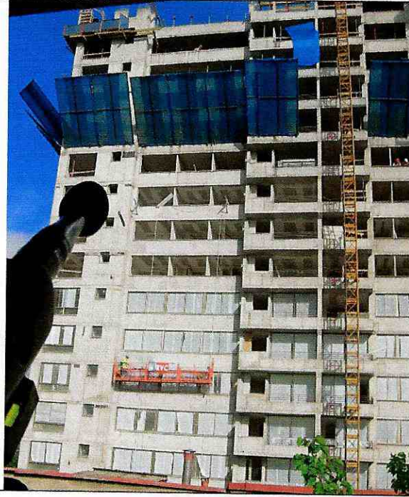
Figura 4.1.1- Fuente de Ruido: Faenas de construcción de edificio de 19 pisos
