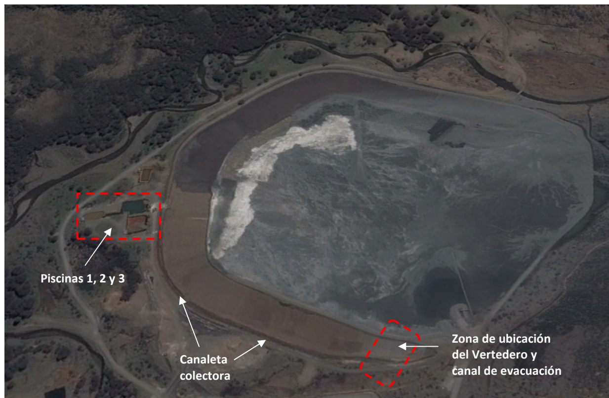
Figura N°1. Instalaciones de evacuación de aguas superficiales.
