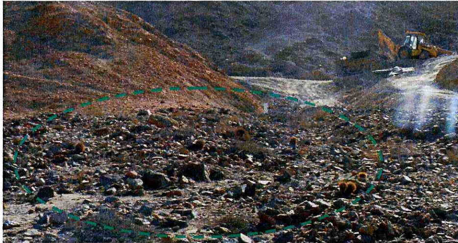
Figura 6. Presencia de maquinaria en sector B de relocalización de cactáceas
