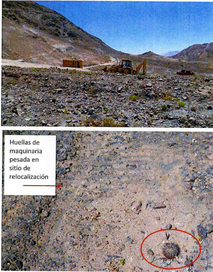
Figura 5. Presencia de maquinaria en sector B de relocalización de cactáceas
