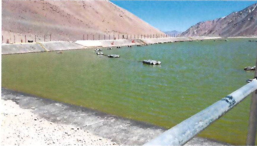
Imagen 13. Piscina de acumulación de aguas contactadas n° 2. Las flechas rojas indican las marcas que dejó el agua en un momento que la piscina supero su capacidad.
