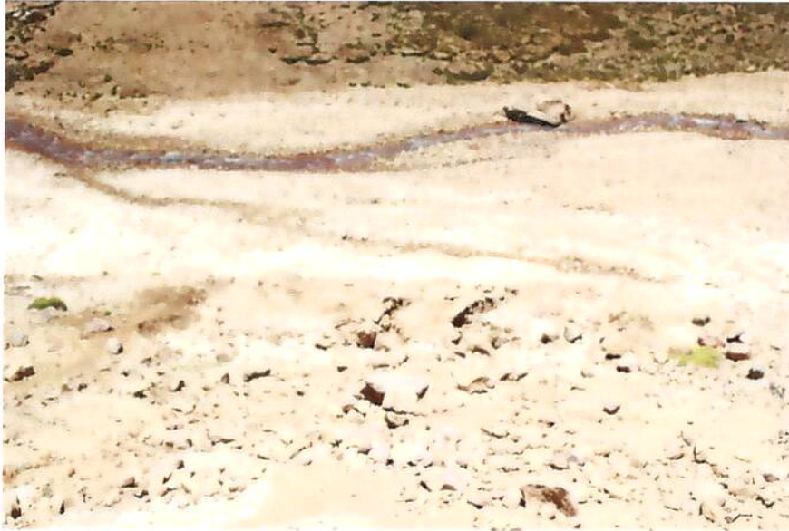
Imagen 22. Cárcavas en el talud hacia el Río Estrecho, evidencia de escurrimiento de aguas de contacto.
