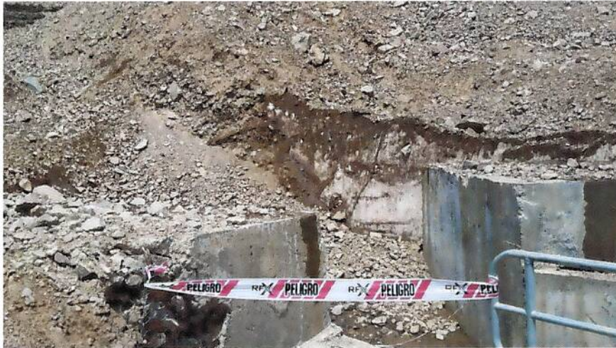
Imagen 7. Estación 4 Obra de Captación 6. Existe material sedimentario sobre depósitos de firn, que según la empresa CMNSpA fue cubierto por acción de las obras en el lugar.
