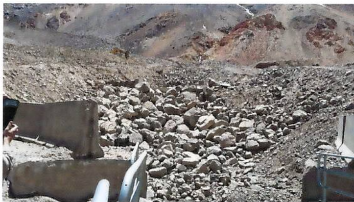
Imagen 6. Captación A Quebrada La Negra y obras de disipación de energía. Nótese el espesor del depósito sedimentario no consolidado.
