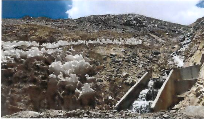
Imagen 8. Obra de Captación Quebrada 0. Al costado izquierdo depósito de firn.
