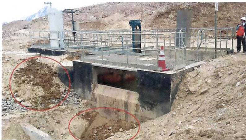
Imagen 9. Cámara de Captación Restitución (CCR). Círculos rojos indican sedimento húmedo. Nótese sedimento en la pared izquierda de la CCR. Imagen tomada mirando al Nor-Oeste.
