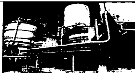
FOTO 5: Estanques de Licor Negro Concentrado, área evaporación
