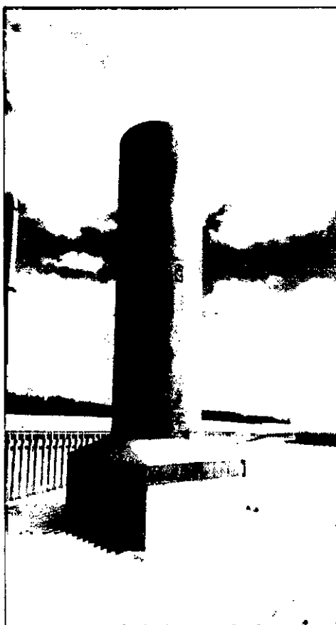
Fotografía 5.6 Chimenea Estanque Disolvedor
