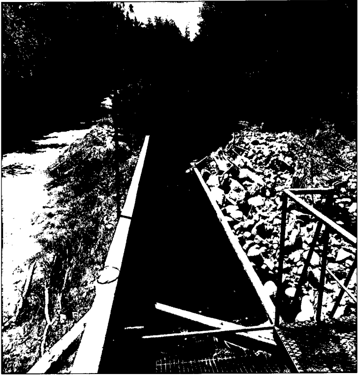
Foto N° 2. Bocatoma utilizada para captar las aguas
