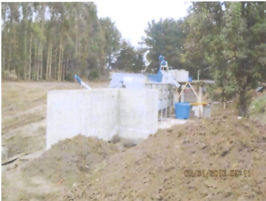
Figura 2 Cámara de reparto de caudales y tornillo en funcionamiento
