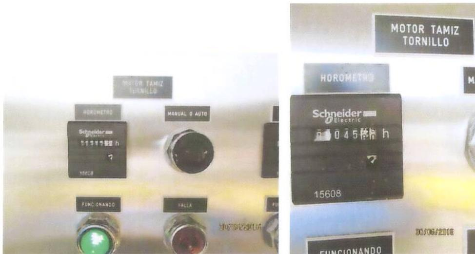
Figura 5 Tablero eléctrico y horómetro etapa de desarenado
