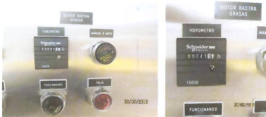
Figura 7 Horómetro soplador de aire (etapa de tamizado y desarenado)
