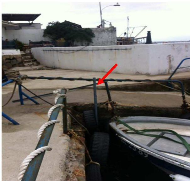
Figura 5. Instalación de mareógrafo en Muelle de Club de Yates de Quintero, la flecha roja indica posición de mareógrafo.
