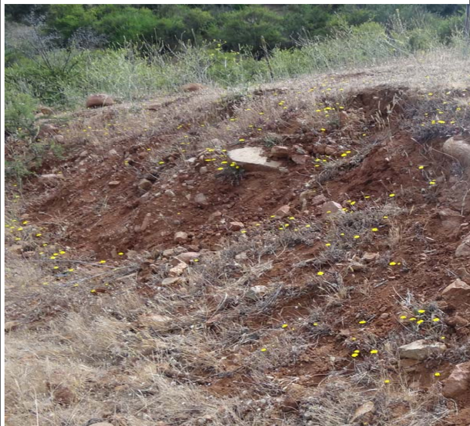
Figura 2. Vista de Talud con deslizamiento de suelo y arrastre de piedras
