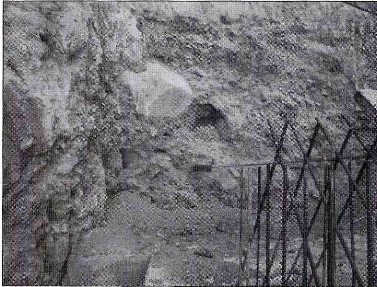
Fotografía 5-2: Excavación de ladera en materiales no consolidados de origen glacial, vista A (depósitos morrénicos).
