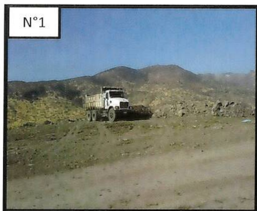
Foto N°1: Recuperación de zona afectada con cobertura en espesor de 30 a 50 cm aprox.
