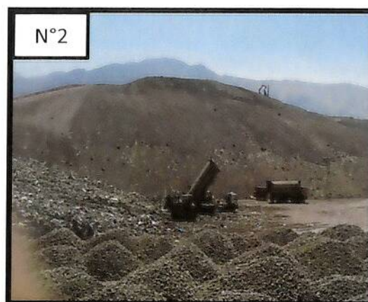
Foto N°2: Traslado de Frente de Trabajo a Celda impermeabilizada ubicada al Sur-Oriente del RSLLC, a un kilómetro del área afectada.
