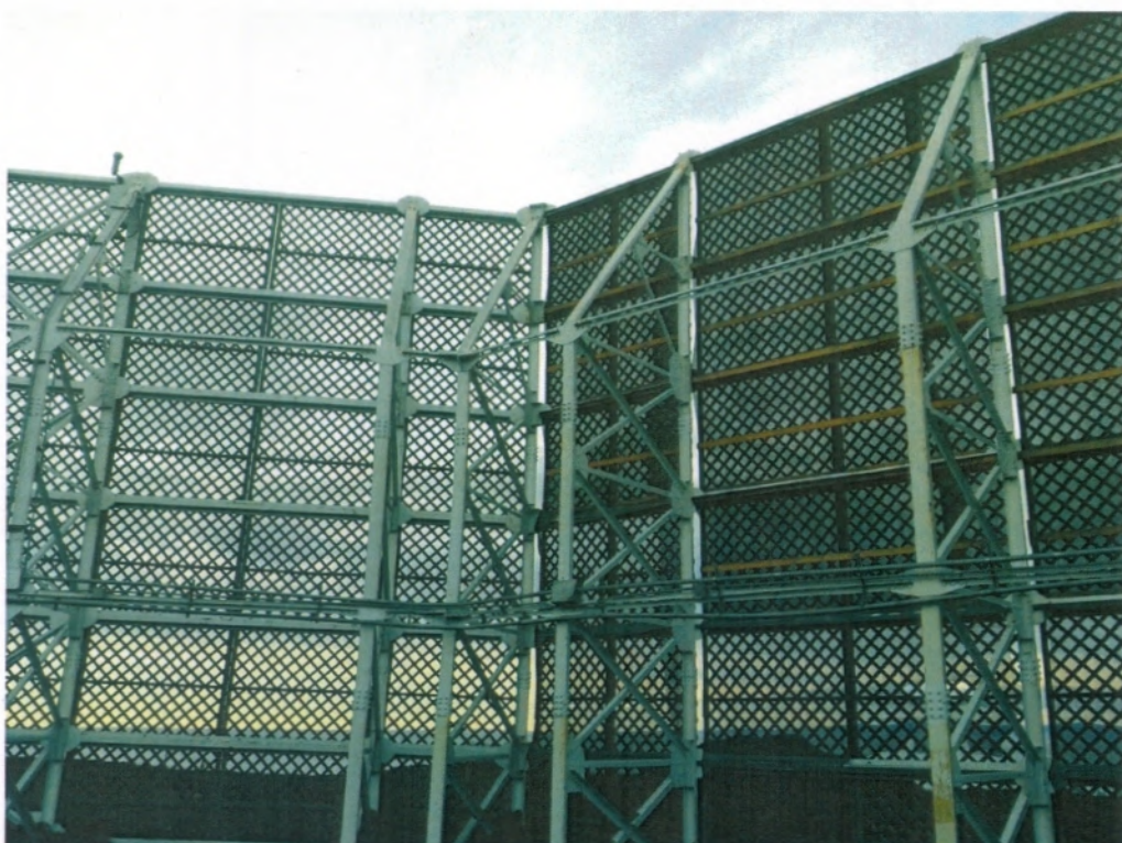
Fotografía N°3, Malla Raschel a sotavento (lado derecho de la fotografía) y sin malla hacia el Norte del Stock Pile (lado izquierdo de la fotografía)
