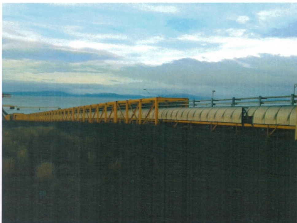
Fotografía N°8, Correa Transportadora desde Stock Pile hacia el Muelle.
