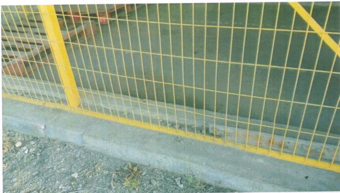
Fotografía N°2, Pretil de contención de derrames en bodegas RESPEL
