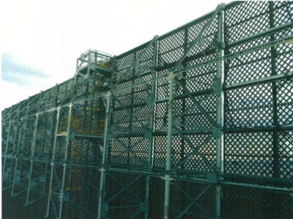
Fotografía N°1, Malla Raschel en barrera eólica a sotavento del Stock Pile
