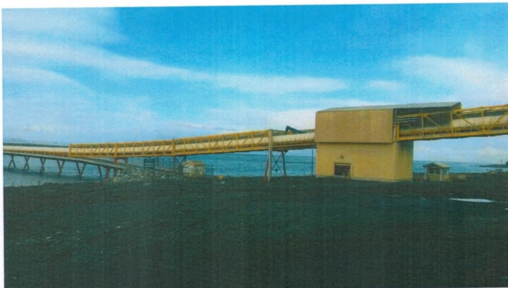
Fotografía N°9, Correa Transportadora desde el Stock Pile al Muelle
