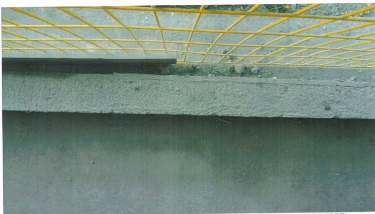
Fotografía N°3, Detalle del pretil de contención de derrames en bodegas RESPEL
