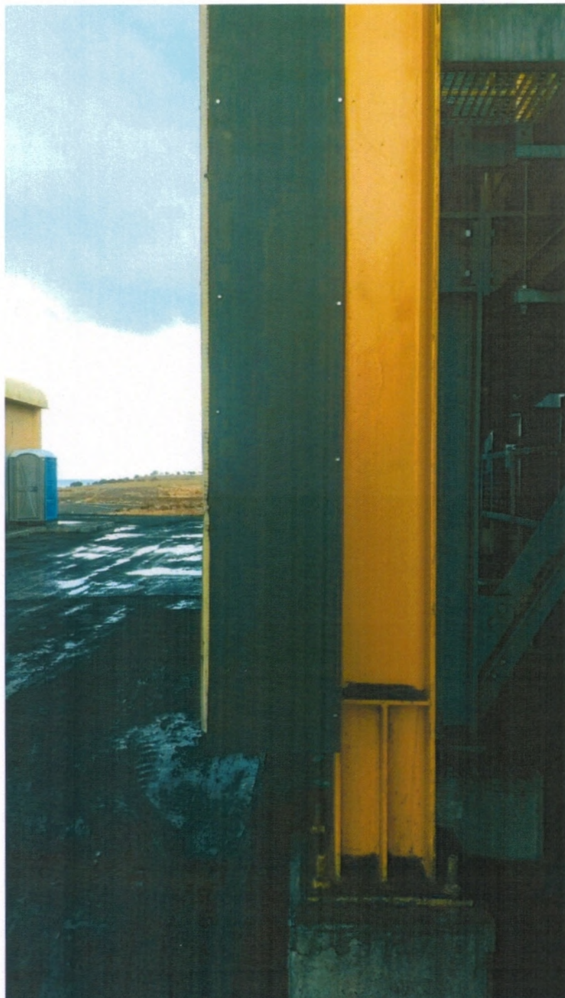
Fotografía N°14, Detalle de la pared aislante de 33 cm de espesor
