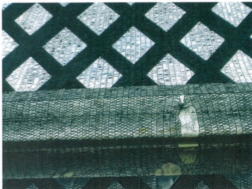
Fotografía N°2, Detalle de la Malla Raschel instalada
