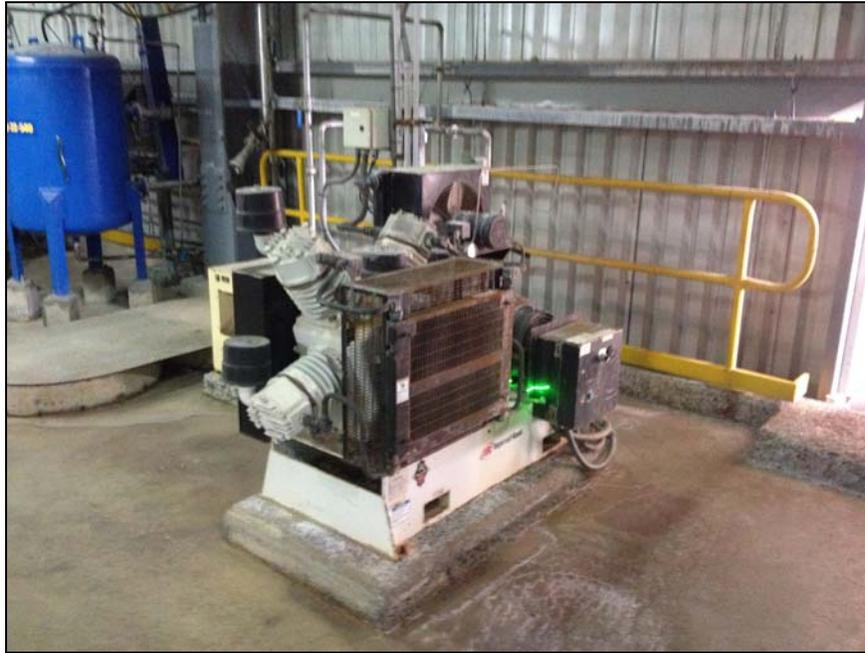
Fotografía 7.9 Compresor de aire de respaldo
