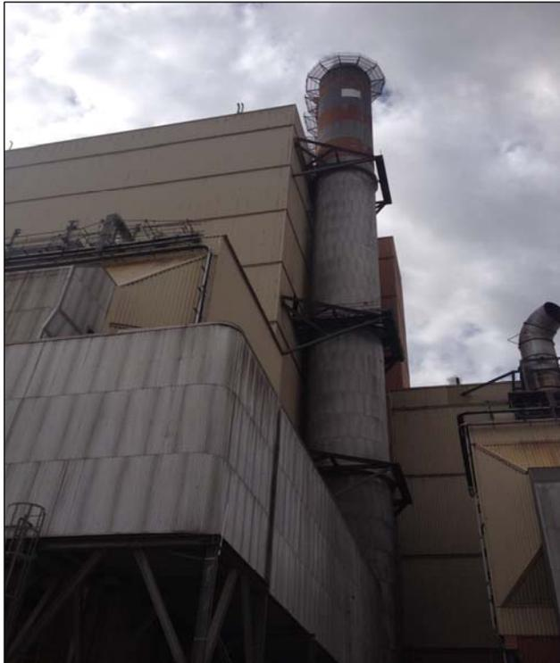
Fotografía 5.2 Chimenea común de la caldera recuperadora y de poder
