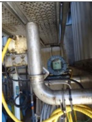
FOTO 13 Sensores/Indicador de Conductividad Foso 6,, área Lavado.
