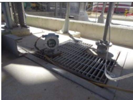
FOTO 16 Sensores/Indicador de Nivel Foso 2, área Caustificación.
