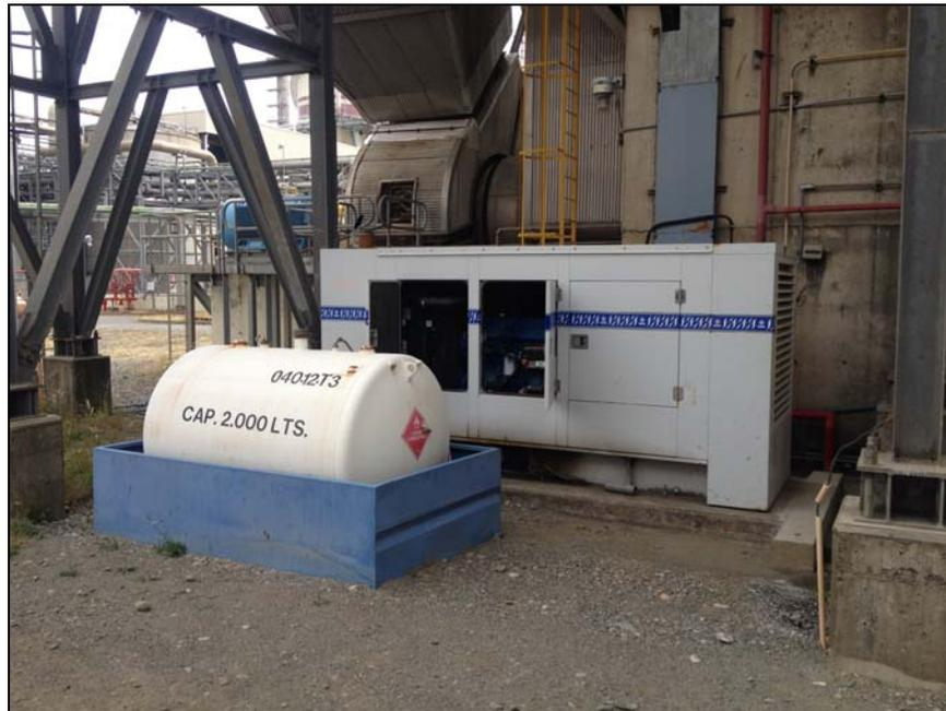
Fotografía 7.8 Generador eléctrico de respaldo
