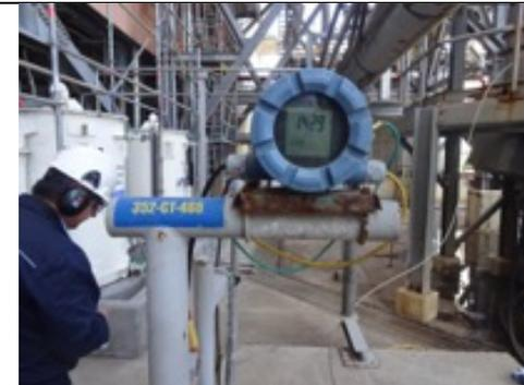
FOTO 9 Sensor Indicador de Conductividad Foso 4, área caldera recuperación
