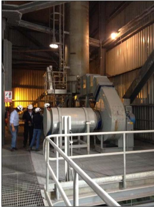
Fotografía 7.7 Ventilador aire combustión quemador dedicado
