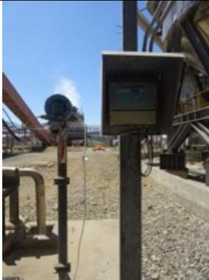
FOTO1: Sensor Indicador de Conductividad Foso 13, área Evaporación
