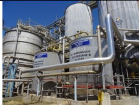
FOTO 5: Estanques de Licor Negro Concentrado, área evaporación
