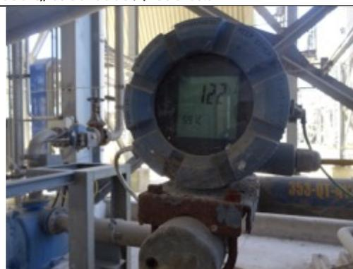
FOTO 17 Sensores/Indicador de Conductividad Foso 2,, área Caustificación.
