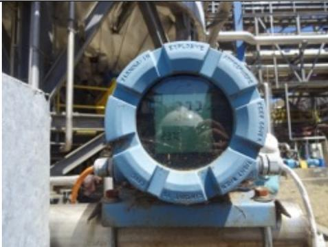
FOTO 4: Sensor Indicador de Conductividad Foso 13, área Evaporación
