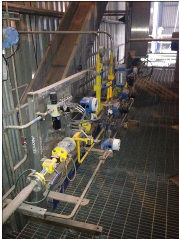
Fotografía 7.6 Tren de GLP quemador o incinerador dedicado
