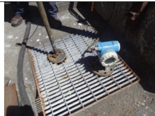
FOTO 15 Sensores/Indicador de Nivel Foso 1,, área Caustificación.
