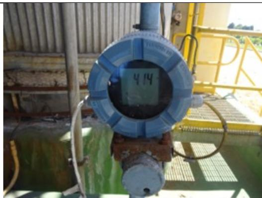
FOTO 14 Sensores/Indicador de Conductividad Foso 1,, área Caustificación.
