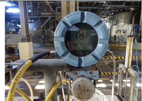
FOTO 12 Sensores/Indicador de Conductividad Foso 6b., área Digestores.
