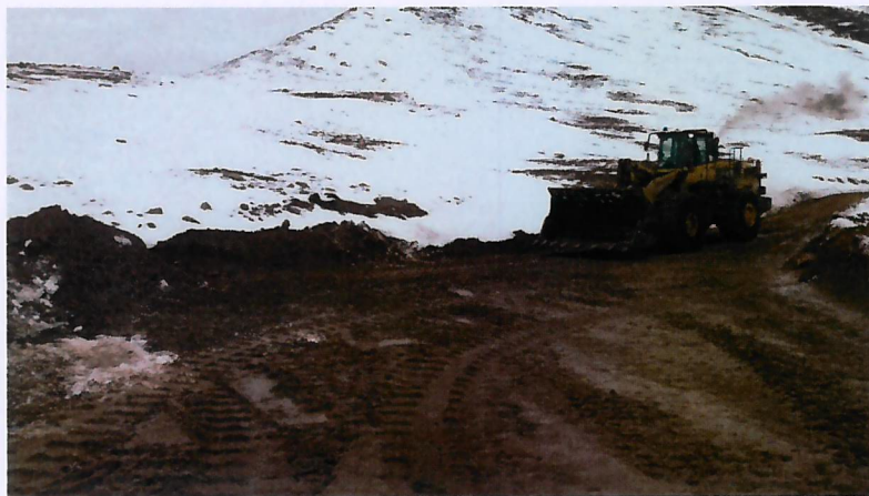
Trabajo de tapado de zanjas una vez ejecutadas las mufas
