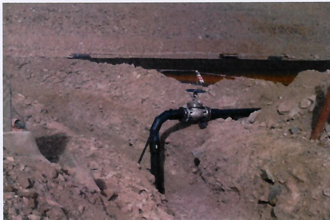
Instalación de válvula en extremo norte piscina N°2.
