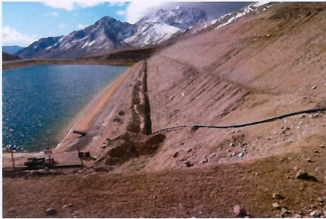
Tendido de cañería costado oriente piscina N°2.
