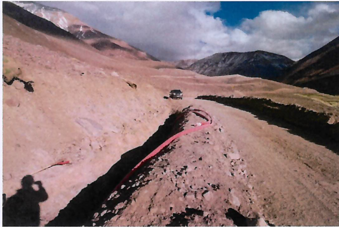
Tendido de cable minero en camino principal. Zanja se encuentra tapada excepto en puntos de empalme del cable.
