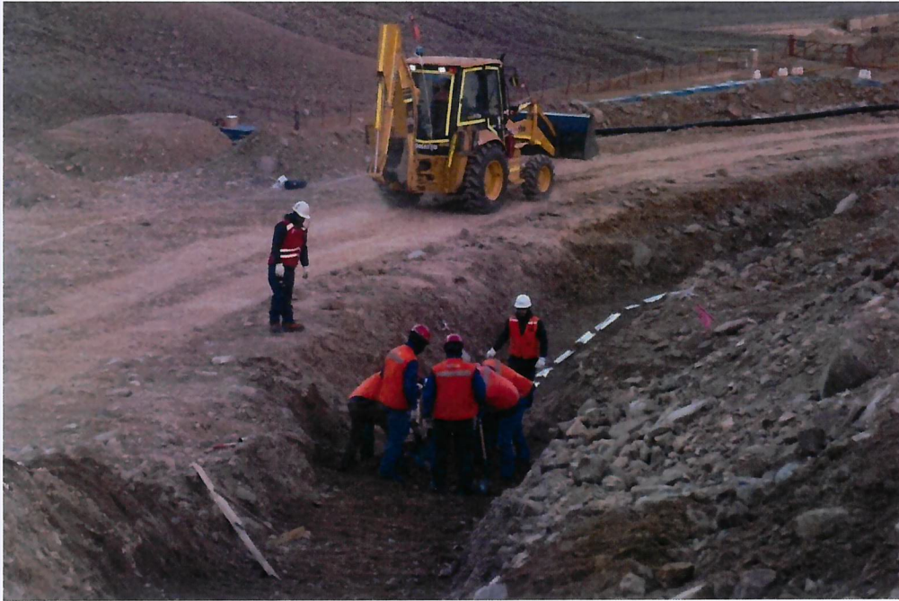
Tapado del Tendido de la cañería
