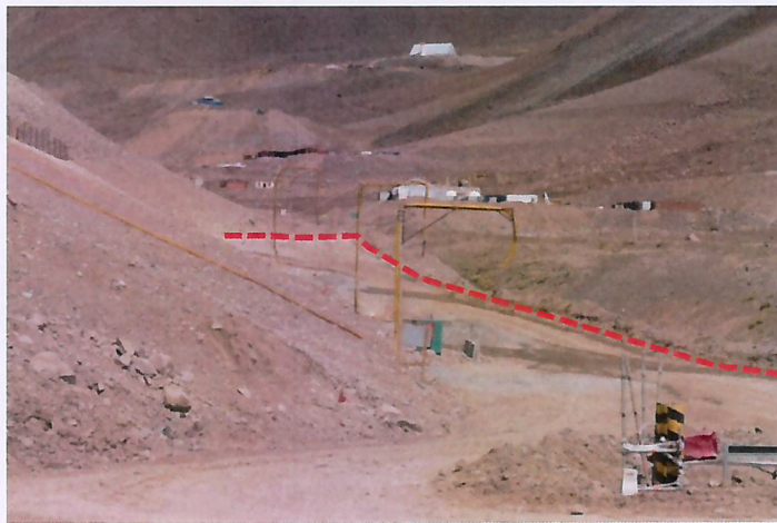
Vista de costado inferior de piscinas de contacto por donde pasará trazado de Indepro.
