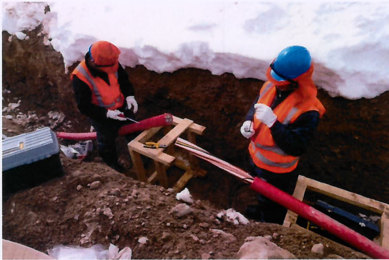
Ejecución Mufa N°1.
