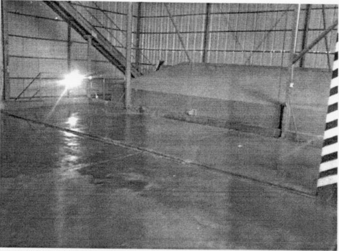
Fotografía N° 3. En área de recepción de materias primas, no se observan derrames, así como tampoco moscas. Además los trituradores de materia prima están con tapa y cerrados
