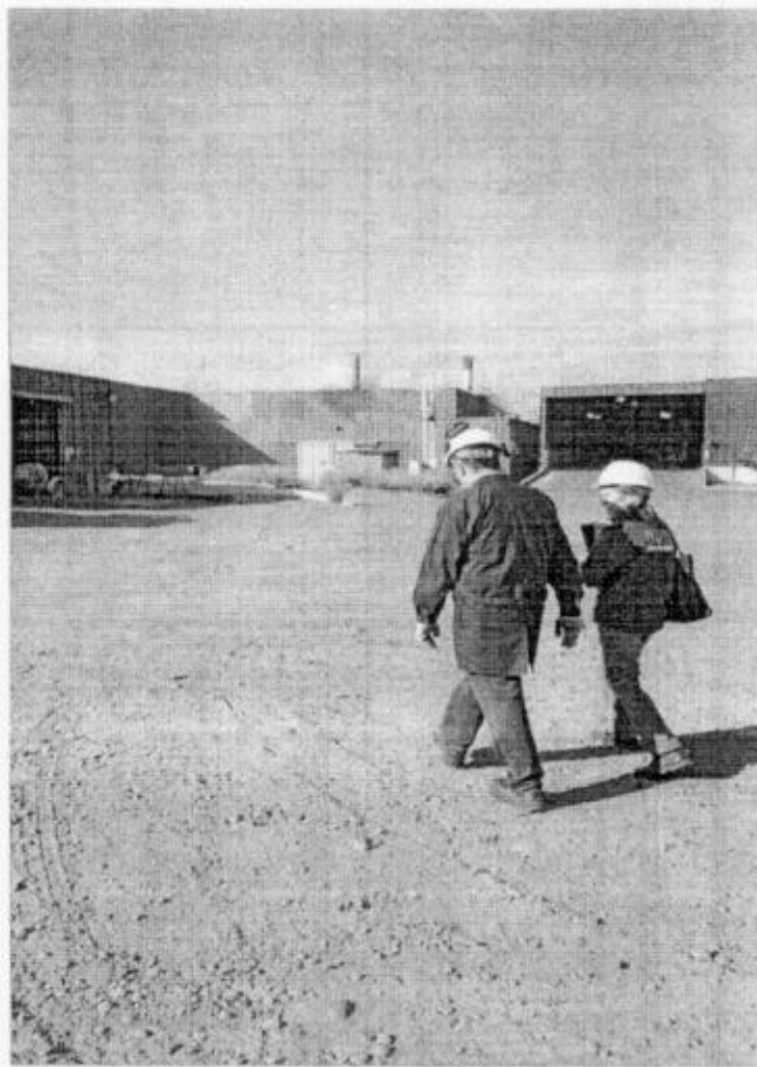
Fotografía 14: Galpón de recepción de la materia prima, se encuentra sin puerta de acceso, permitiendo el escape de olores al exterior y proliferación de moscas.
