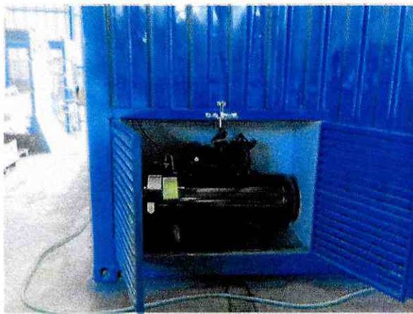
Foto N° 1: Compresor de aire ubicado en compartimento exterior del contenedor.
