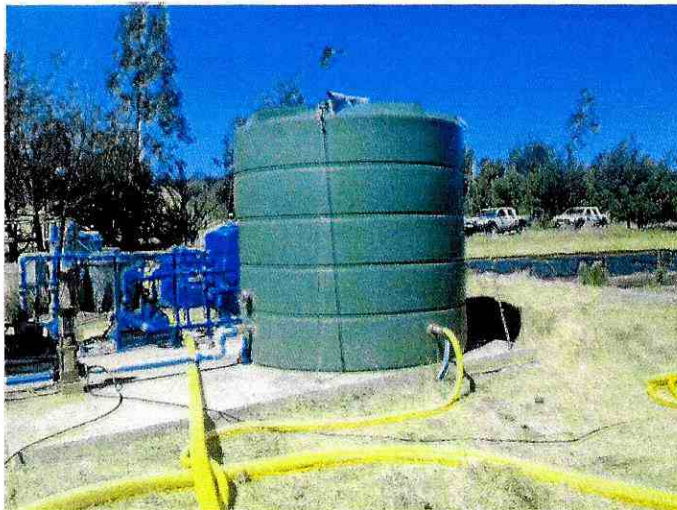
Foto 7: Estanque de acumulación y suministro de agua para el sistema automático de polímeros y de limpieza del tamiz de la prensa de tornillo (a cargo de terceros).
