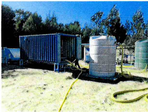
Foto N° 2 y 3 : Estanque de ecualización y acumulación de lodos afluente a la prensa de tornillo (suministros de terceros).
