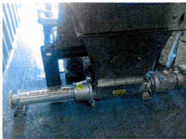
Foto 10 : Bomba de impulsión lodos deshidratados.
