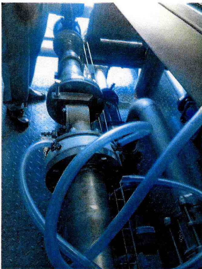
Foto 8 Mezclador en línea polímero- lodo.
