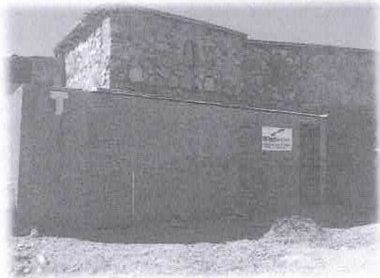
Señalética instalada en la caseta de la PTAS de Parinacota.
