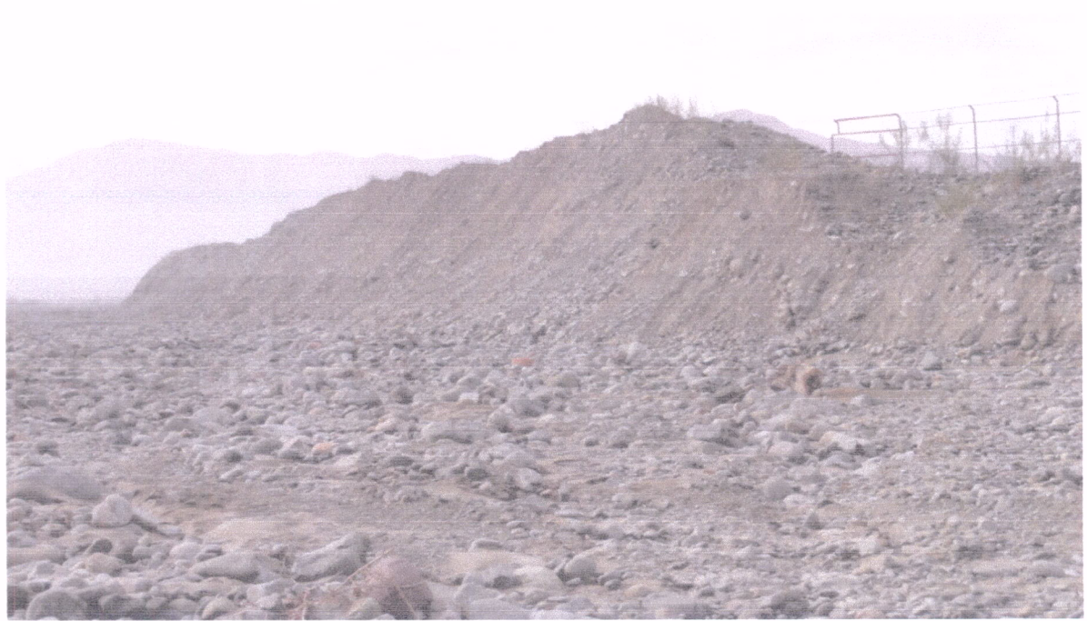
Figura 5. Espigón erosionado estero Codegua
