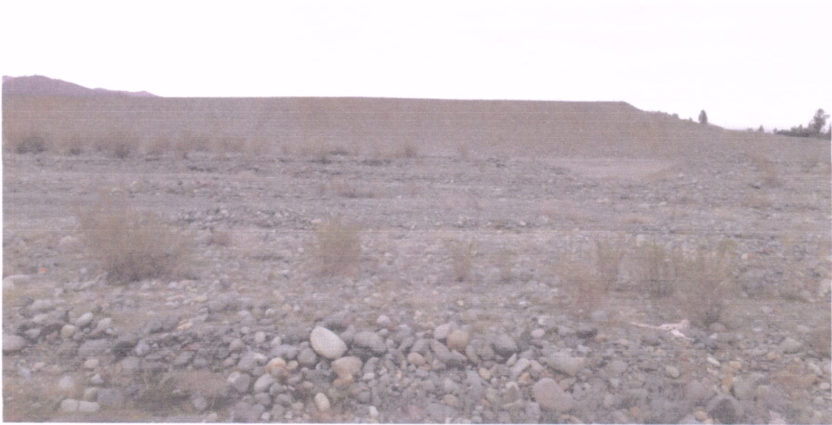
Figura 6. Imagen muro acústico Autódromo de Codegua.
