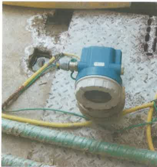
Figura 2: Imagen de sensor de nivel 352-LT-485
