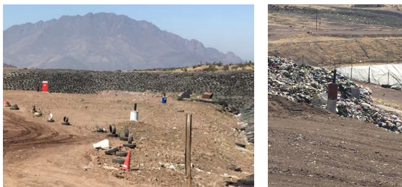
Figura 4 Chimeneas de biogás
