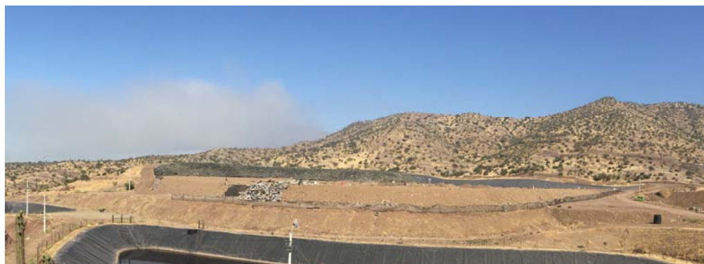
Figura 5 Material de cobertura
