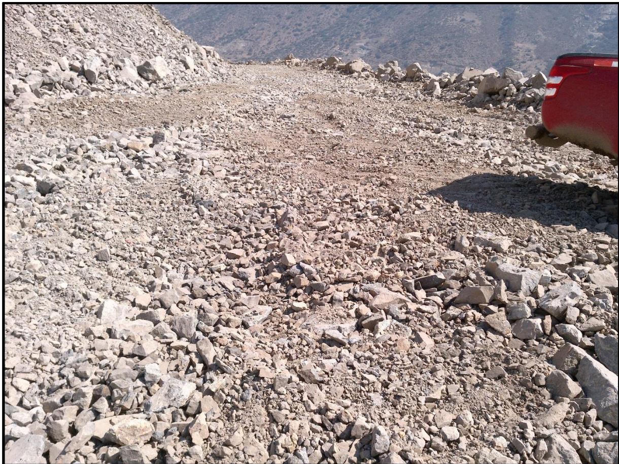
Fotografía N°4: Muestra ensanche o relleno sobre caminos, realizado con estéril.
