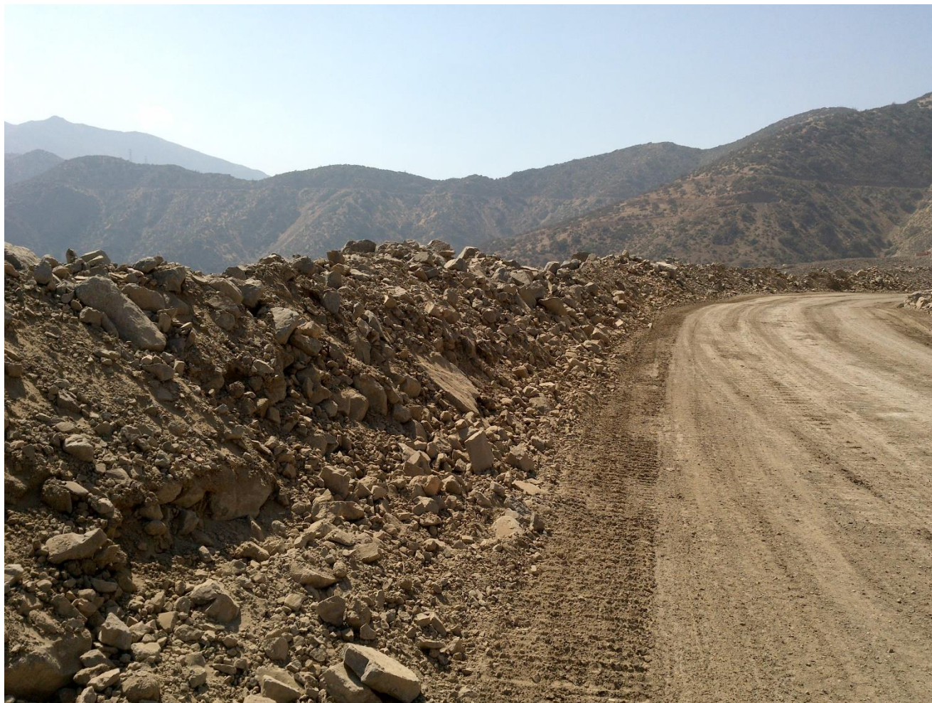
Fotografía N°A1: Parapeto o muro de contención de borde de camino, solicitado por Sernageomin
