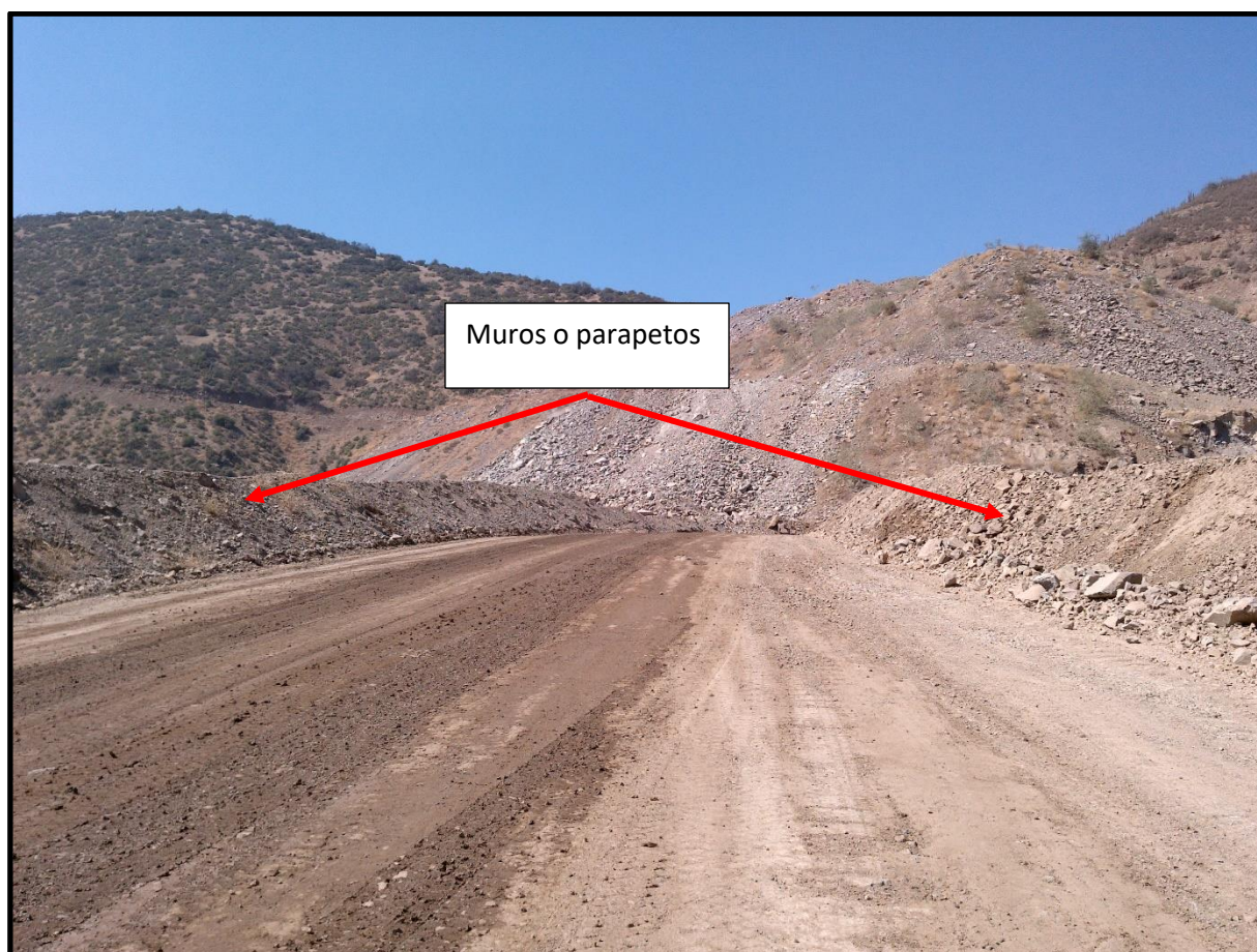
Fotografía N°3: Muestra una de los muros o parapetos en el camino, construidos con material estéril.
