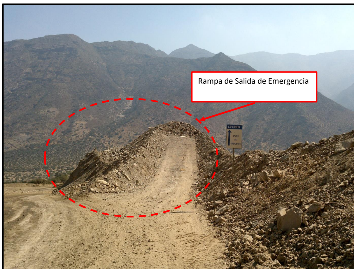
Fotografía N°2: Muestra una de las rampas de salida de emergencia, realizada con material de estéril.
