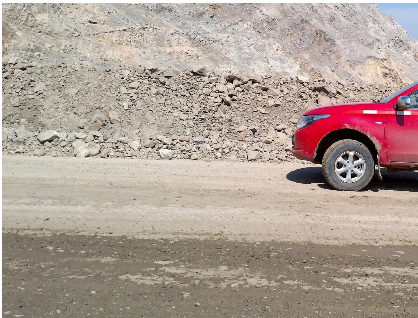
Fotografía N°A2: Parapeto o muro de contención de borde de camino, solicitado por Sernageomin
