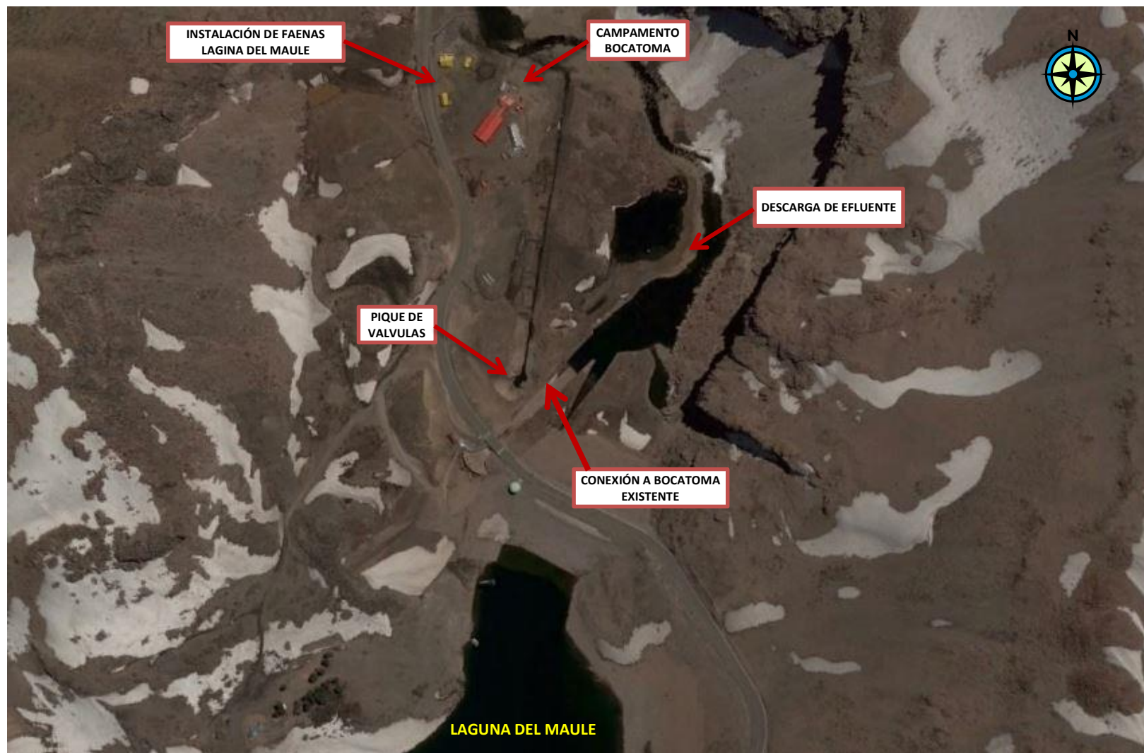
Figura 2. Layout del proyecto (Fuente: Elaboración propia en base a plano contenido en Anexo B, Adenda 2, DIA “Optimización de Obras de la Central Los Cóndores”)
