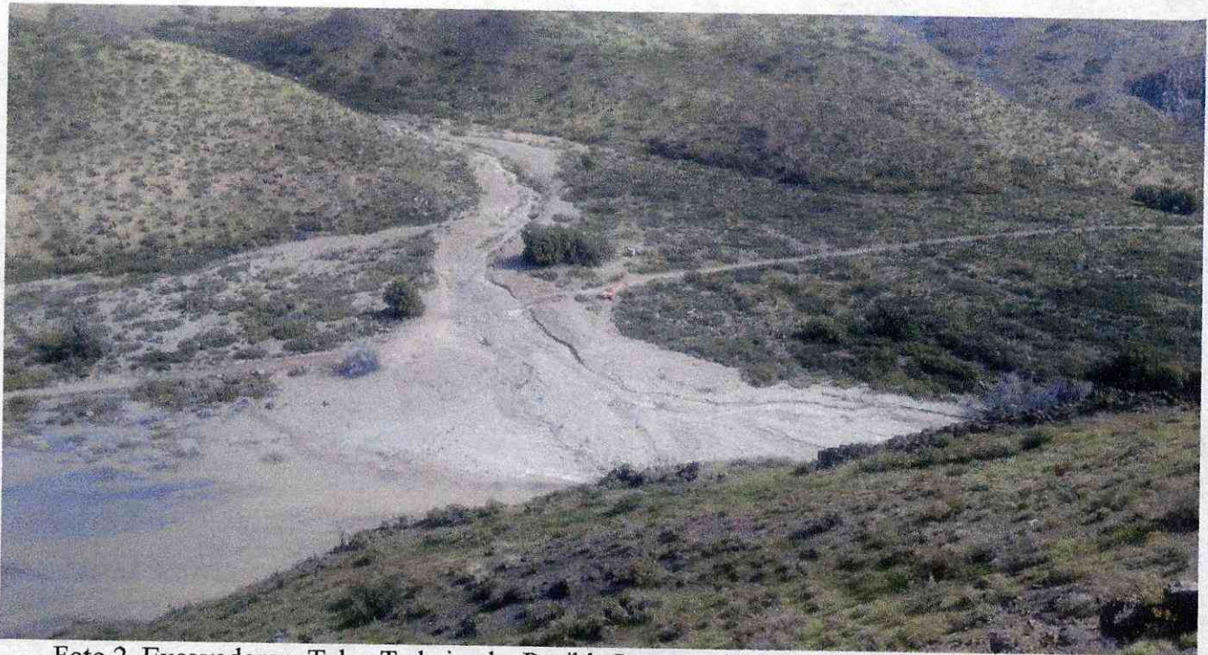
Foto 2. Excavadora y Tolva Trabajando. Posible Intervención Cauce Río Rocín. Octubre 2015.
