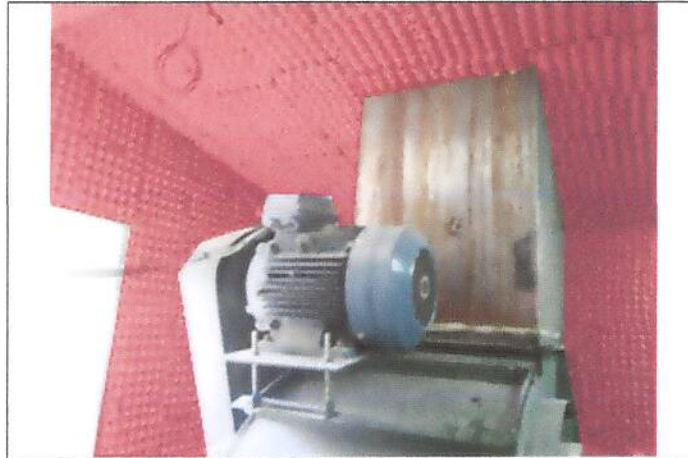
Ilustración 11: Revestimiento interior de encierro de extractor.
