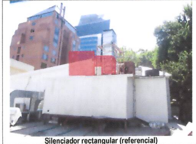
Ilustración 9: Recomendación de silenciador para chimenea de extracción
