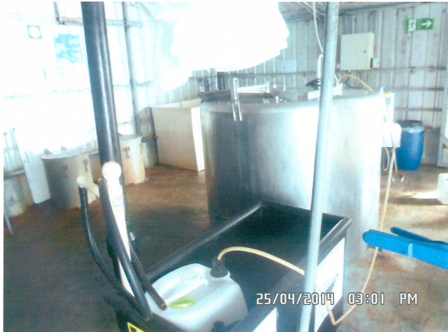
Figura 7: Respaldo fotográfico del estado actual de la plataforma de ensilaje luego de limpiarla y ordenarla.
