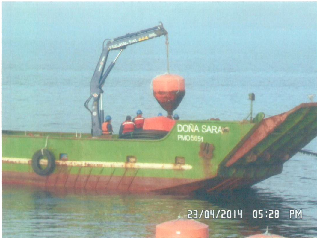
FIGURA 4: Registro fotográfico del retiro de boya tipo pera rota.
