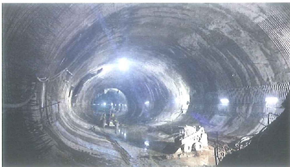
Figura 20. Túneles grandes: túnel estación terminado en etapa de revestimiento
