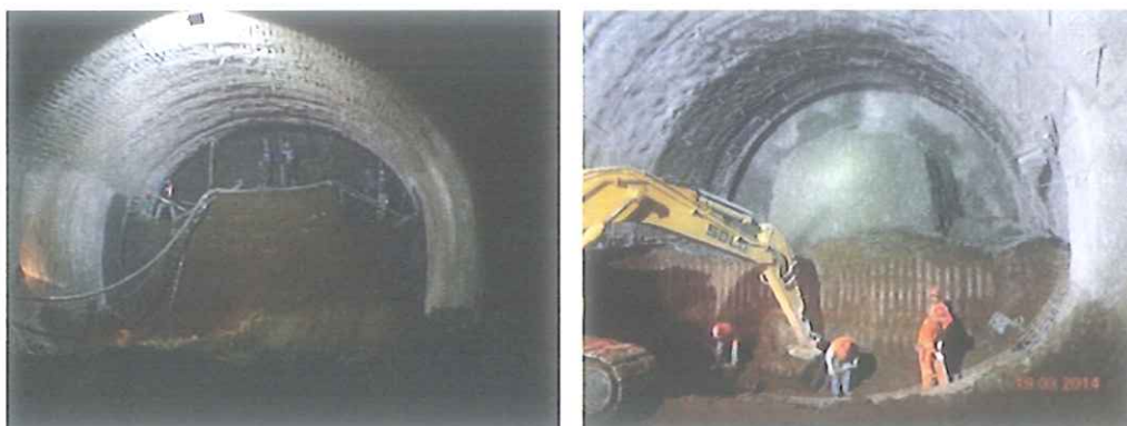
Figura 16. Túneles medianos. Etapa bóveda - banco (izq.), etapa contrabóveda (der.)
