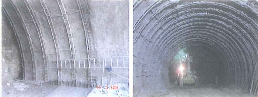
Figura 4. Revestimiento Primario o Sostenimiento: Múltiples avance con hormigón proyectado + mallas + marcos reticulados de acero
