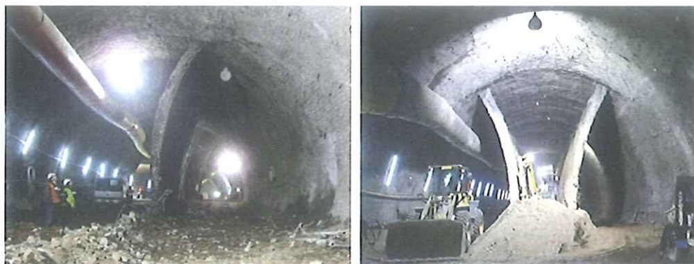
Figura 18. Túneles grandes: side drift simple (izq.), side drift doble (der.)
