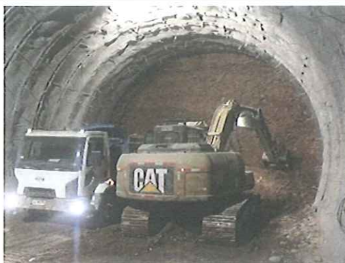
Figura 2. Excavación de la frente y carguío
