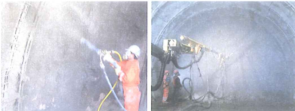
Figura 3. Sistemas de proyección del hormigón. Manual (izq.), Mecanizada (der.)
