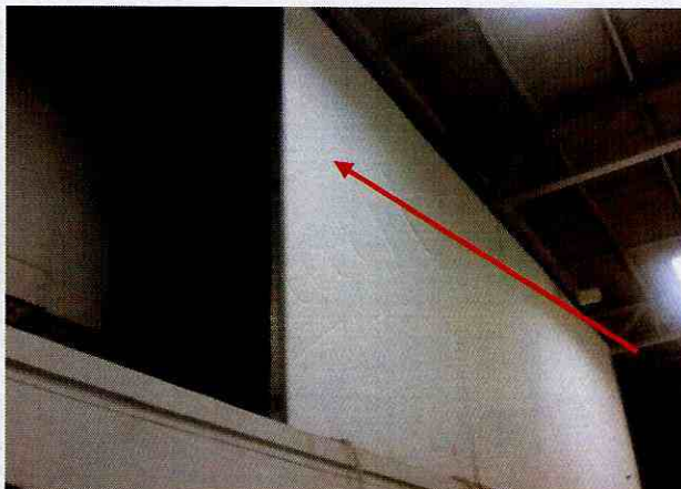
FOTOS DE CIERRE INTERNO CON TERMOPANEL SECTOR BODEGAS UBICACIÓN DE SALA DE CENTRAL DE FRIO
